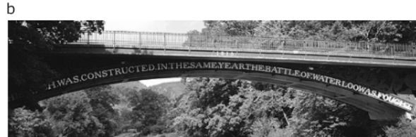
fig.2.2.1a5 Podul Craigellachie , peste râul Spey, Scoția (1815) - ing. Thomas Telford folosește pentru prima dată arce de fontă cu panouri contravântuite. Soluția expresivă este dată aici de prelucrarea capetelor de pod din zidărie într-un stil pitoresc, ce oferă mai degrabă imaginea unor turnuri de apărare.
