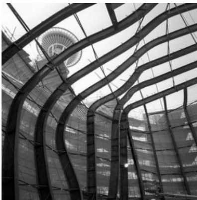
fig.3.3.c Sudura - adevărata revoluție, devenită posibilă datorită proprietăților oțelului, a reprezentat-o sudura. Acest tip de îmbinare face posibilă transformarea ansamblului elementelor puse laolaltă într-un cvasi-continuu (Experience Music Project).
