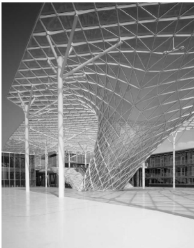
fig.2.6cc Milan Trade Fair , Italia (2002-2005) - arh. Massimiliano Fuksas - o formulă structurală cu ochiuri cvadrangulare și triangulare permite materializarea 'vălului' de metal și sticlă ce formează coloana vertebrală a ansamblului.
