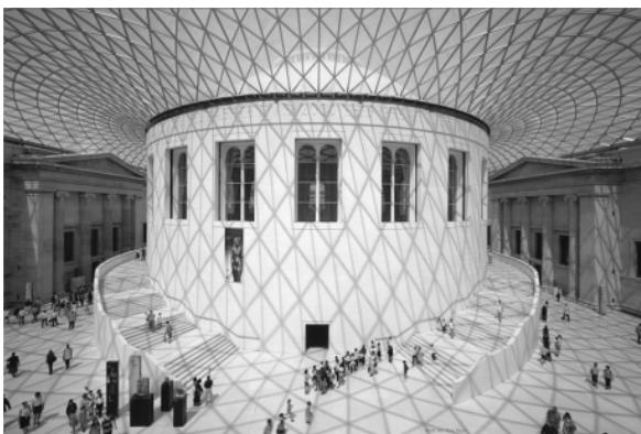
fig.2.6j Acoperișul Great Court - British Museum , Anglia (1994-2000) - arh. Norman Foster - soluția aparent simplă a formei toroidale, ușor asimetrică, proiectată sub controlul inginerului Stephen Brown de la Buro Happold, mizează din plin pe tehnologia informatică de ultimă oră, cea care face posibilă deopotrivă proiectarea și materializarea numărului mare de componente și noduri diferite.
