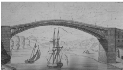
fig.2.2.1a3 Podul Sunderland , WEARMOUTH, Anglia (1796) - conceput de ing. Thomas Paine în 1787 și patentat șase ani mai târziu de Rowland Burdon - structura de cca. 72m deschidere depășea tot ce s-a construit până atunci în materie de poduri de fier.
