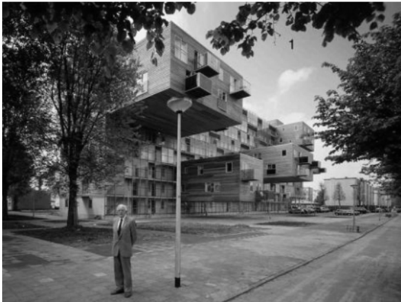
fig.2.6h WOZOCO Housing , Olanda (1994-1997) - arh. MVRDV - invizibilă, structura metalică primește totuși un rol deosebit de important, acela de a prelua apartamentele care, nemaigăsind spațiu în cadrul volumului construit, au ajuns să fie suspendate pe fațadă.
