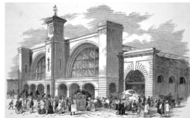
fig.2.2.1e4 King's Cross , LONDRA, Anglia (1851-1852) - arh. Lewis Cubitt alege exprimarea în fațadă a structurii de acoperire a peroanelor.
