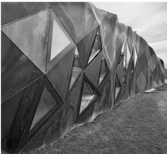
fig.2.6kk Pavilionul de la Hinzert , Germania - arh. Wandel Hoefer Lorch și Hirsch - deși mizează de la început pe imaginea oferită de sistemul portant, forma se supune cerințelor structurale doar în măsura în care acestea impun unghiurile minimale dintre componentele triunghiulare care formează sistemul, astfel încât lucrând împreună ca un continuu să genereze o placă cutată suficient de rigidă.
