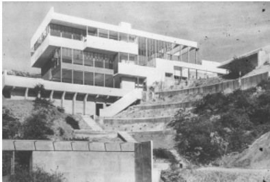
fig.2.4.5f Lovell Health House , LOS ANGELES, S.U.A. (1927-1929) - arh. Richard Neutra - expresie arhitecturală derivată direct din structura scheletală finisată cu panouri ușoare. Scheletul dens de oțel, integrat în compoziția abstractă de plane transparente și opace, este expus pe alocuri intenționat, devenind montant al tâmplăriei sau suport al balcoanelor în consolă.
