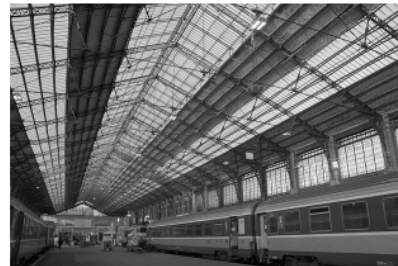
fig.3.6.3c Gara Austerlitz - ferme Polonceau permit aici acoperirea peroanelor pe o deschidere de 52,55m.
