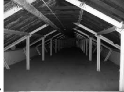
fig.2.2.1b1 Ditherington Flax Mill, SHREWSBURY, Anglia (1796) - arh.ing. Charles Bage - construcție pe 5 niveluri care folosește pentru prima dată un schelet interior complet din fontă.
