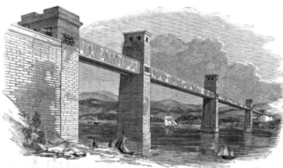
fig.2.2.1a13 Britannia Bridge , (1845-1851) - ing. Stephenson și arh. Thompson, ajutați de inginerii consultanți Fairbairn și Hodgkinson - un extraordinar exemplu de colaborare între specialiști de marcă - soluția structurală cu două tuburi de secțiune rectangulară, realizate din plăci nituite de fier forjat astfel încât să formeze grinzi continue, reprezintă o noutate absolută în domeniu.
