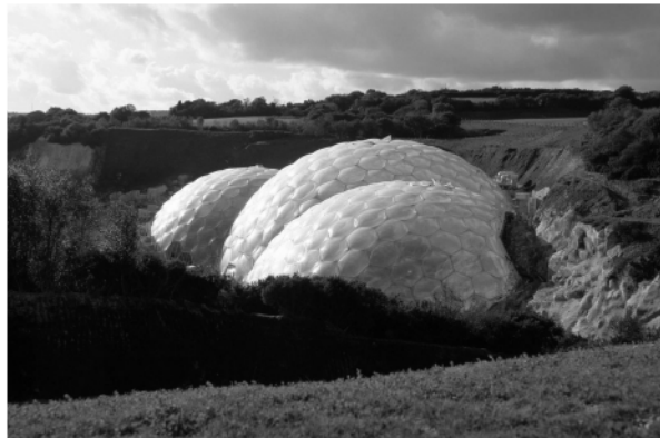
fig.2.6l Eden Project , USA (1995-2001) - arh. Nicholas Grimshaw și inginerii de la Anthony Hunt Associates și MERO - dorința de a reduce la minim consumul de material și umbra lăsată de componentele structurale, determină aici, precum în cazul serelor din secolul XIX, atât forma sistemului structural cât și pe cea a sistemului de închidere.
