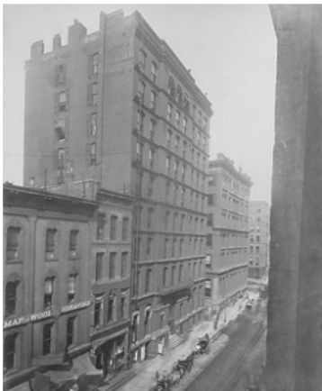
fig.2.3.1e Montauk Block , CHICAGO, S.U.A. (1882-1883) - arh.ing. John Root și arh. Daniel Burnham - cea mai înaltă clădire din Chicago la momentul finalizării, avea să se dovedească remarcabilă prin însăși forma de abordare a proiectării, caracteristică mai degrabă construcțiilor funcționale. Acest edificiu cu zece niveluri era susținut de un schelet metalic interior și o fațadă portantă de zidărie. Contribuția importantă pe care John Root avea să o aducă în această construcție rezidă în două inovații esențiale ce vin mai degrabă din domeniul ingineriei: placarea grinzilor structurale cu elemente ceramice cu goluri, ce creștea substanțial rezistența la foc a construcției, și sistemul de fundare, cu șine de cale ferată încastate în beton, ce făcea posibilă distribuția greutății unei clădiri de asemenea dimensiuni pe solul mlăștinos al orașului Chicago.
