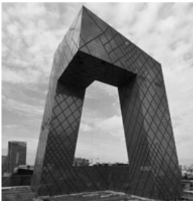
fig.2.6dd CCTV , China (2002-2010) - arh. Ole Scheeren și Rem Koolhaas - rețeaua structurală diagonală exprimată în fațadă, ce permite menținerea în picioare a formei imposibile, are aici rolul de a îmbogăți expresia arhitecturală.
