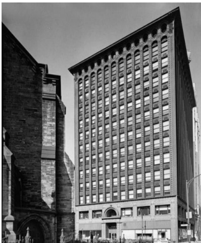
fig.2.3.1q Guaranty Building , Buffalo NEW YORK, S.U.A. (1896) - ing. Dankmar Adler, arh. Louis Sullivan - o nouă temă în designul zgârie norilor - stâlpii parterului devin aproape liberi, permițând pătrunderea spațiului sub clădire și generând astfel o puternică senzație de volum.
