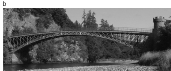
fig.2.2.1a5 Podul Craigellachie , peste râul Spey, Scoția (1815) - ing. Thomas Telford folosește pentru prima dată arce de fontă cu panouri contravântuite. Soluția expresivă este dată aici de prelucrarea capetelor de pod din zidărie într-un stil pitoresc, ce oferă mai degrabă imaginea unor turnuri de apărare.
