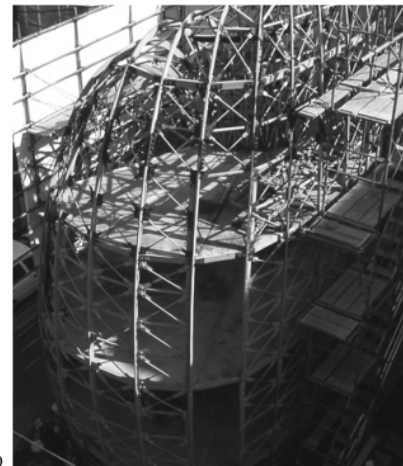
fig.2.6v Natural Ellipse house, Japonia (2000-2002) - arh. Masaki Endoh - această formă toroidală se materializează prin intermediul unui schelet metalic cu 24 de inele eliptice, invizibile în spatele cojii albe .
