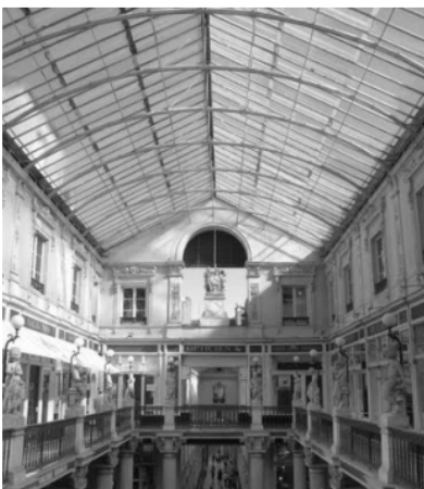
fig.2.2.1d5 Passage Pommeraye , NANTES, Franța (1843) - arh. H. D. Gasselín și arh. J.B. Buron - acoperișul de metal și sticlă ce protejează o zonă de tranziție care face legătura între două străzi aflate la 9,40m diferență de nivel, contribuie esențial la creșterea gradului de intimitate și, implicit, a calității spațiului.
