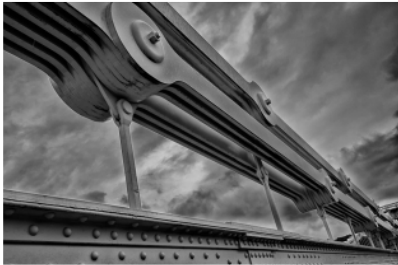
fig.3.4.e Structură tensionată cu lanțuri din fier forjat - (Menai bridge).
