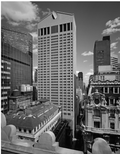
fig.2.5.2b AT&T building , NEW YORK, S.U.A. (1984) - arh. Philip Johnson - structura modernă de oțel rămâne invizibilă în spatele aparentei masivități a plăcilor de marmură roz, care o îmbracă. Dincolo de trimerite istorice, este reluată chiar tratarea tripartită a fațadelor și accentuarea verticalelor, utilizate și în perioada Art-Deco, ce aveau pe vremea lui Sullivan rolul de a accentua înălțimea devenită posibilă tocmai datorită structurilor metalice.
