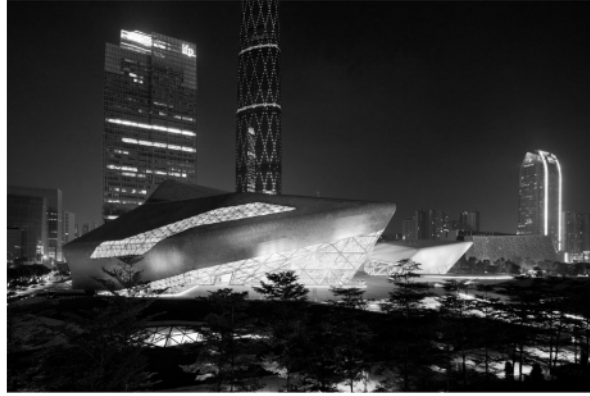
fig.2.6hh Guangzhou Opera House , China (2003-2010) - arh. Zaha Hadid - rețeaua metalică triangulată, de formă liberă, care împachetează sălile din beton, este exprimată deopotrivă în exteriorul și interiorul uriașelor 'pietricele' care compun acest ansamblu.
