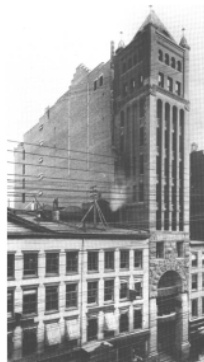
fig.2.3.1k Tower Building , NEW YORK, S.U.A. (1888-1889) - prima clădire construită pe noul sistem la New York, soluția fiind impusă de amplasamentul extrem de îngust pe care o variantă cu fațadă de zidărie nu era fezabilă. Ornamentul rămâne aici istorist.
