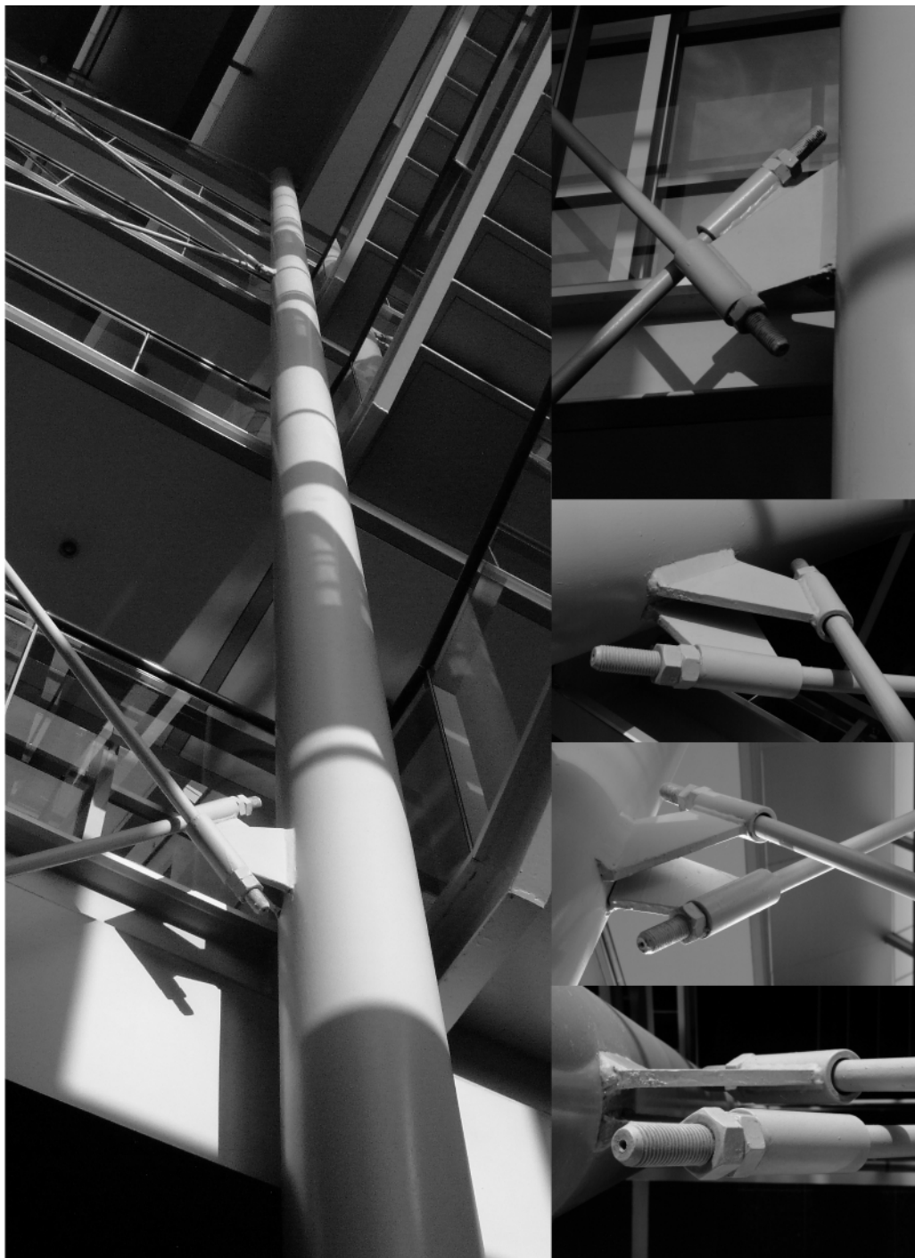
fig.7.4.5g Hol 'atrium' - contravântuiri diagonale (foto Hârța)
