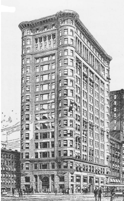
fig.3.7.5c Old Colony Building - dincolo de aparența marcată de exteriorul ce amintește de construcțiile de zidărie, această clădire beneficiază de cel mai avansat sistem structural al momentului. Un sistem structural cu cadre portal, care permitea mărirea rigidității construcției în ansamblu, absolut necesară pentru a continua creșterea pe înălțime. Având în vedere prezența puternică a acestor componente, soluția structurală obliga suprapunerea unor elemente de compartimentare peste zonele de rigidizare, reducând astfel flexibilitatea spațiului interior.
