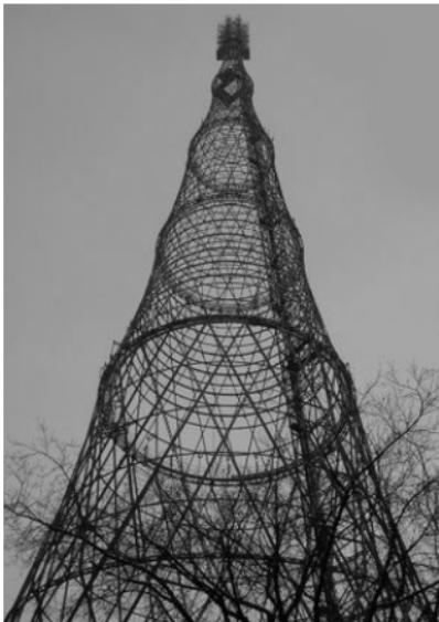
fig.2.4.3d Turnul Radio, MOSCOVA, Rusia (1922) - ing. Wladimir Grigorjewitsch Schuchow - deși propunerea inițială ar fi fost mai înaltă decât turnul Eiffel, datorită sistemului constructiv cu paraboloizi hiperbolici reticulați, pus la punct de Schuchow pentru turnuri de apă, ar fi trebuit să cântărească un sfert din greutatea acestuia.
