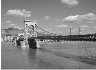
fig.2.2.1a11 Pont Tournon-sur-Rhône , Franța (1824) - ing. Marc Seguin - inovația tehnică o reprezintă înlocuirea lanțurilor de suspendare, cu cabluri.
