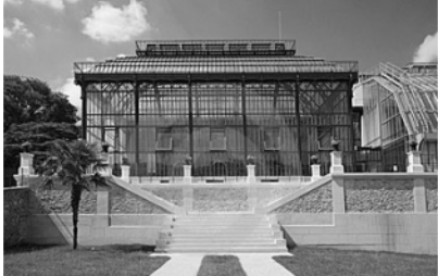
fig.2.2.1c2 Jardin des Plantes, PARIS, Franța (1833-1836) - arh. Charles Rohault de Fleury - prima seră de pe continentul european, lipsită complet de ornament stilistic. Dincolo de dimensiunile impresionante obținute cu o structură exclusiv metalică, se remarcă fațada de fontă multietajată care servește și ca suport al acoperișului.
