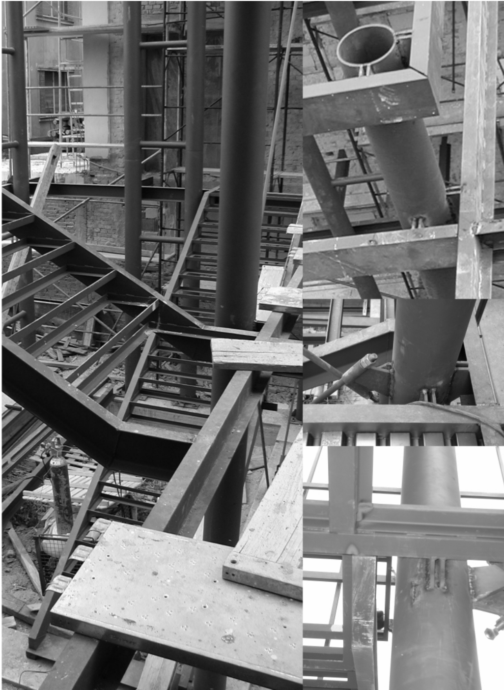
fig.7.4.5d Hol 'atrium' - detaliu de îmbinare stâlp-grindă excentric - șantier (foto Hârța)
