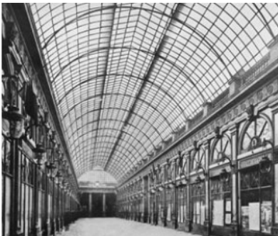
fig.2.2.1d4 Galerie d'Orleans , PARIS, Franța (1829-1831) - arh. Pierre Fontain - acoperișul din fier forjat și sticlă reușește să ofere o senzație de 'libertate și deschidere' similară cu cea din spațiile exterioare.
