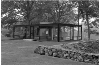
fig.2.5.2a Glass House , NEW CANAAN, Connecticut, S.U.A. (1947) - arh. Philip Johnson - structura portantă se retrace în planul fațadei transparente, alterând imaginea tectonică tipică modernismului raționalist.
