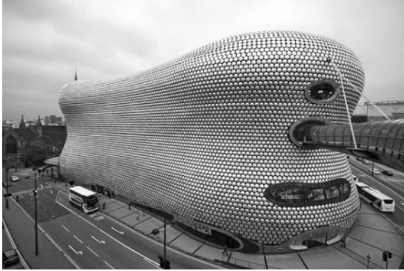
fig.2.6t Centrul comercial Selfridges din Birmingham, UK (1999-2003) - arh. Future System, ing. Arup - forma 'bloby' este obținută printr-o fațadă din beton torcretat agățată pe o structură metalică în cadre dispuse neregulat, conformă cu cerințele funcționale.
