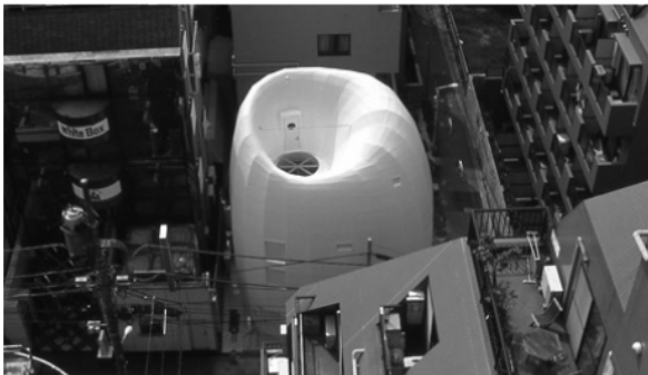
fig.2.6v Natural Ellipse house, Japonia (2000-2002) - arh. Masaki Endoh - această formă toroidală se materializează prin intermediul unui schelet metalic cu 24 de inele eliptice, invizibile în spatele cojii albe .
