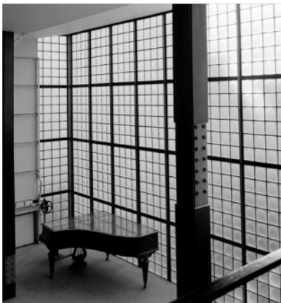
fig.3.7.5d Maison de Verre - scheletul structural este accentuat aici într-o formulă nemaîntâlnită, fiind pus în valoare atât la exterior cât și la interior. În sala de așteptare a cabinetului medical spațiul se extinde pe două niveluri, nu pentru a oferi un mare salon, ci pentru a expune ostentativ acele îmbinări cu buloane și nituri dintre stâlpii și grinzile care fac posibil acest adevărat miracol.
