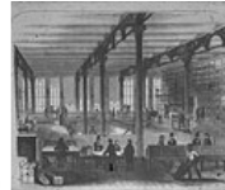
fig.2.2.1g5 Hopkins Store , Murray Street, NEW YORK, S.U.A. (1875) - constr. James Bogardus - soluție ornamentală kitsch, mai ieftină decât piatra, în care proporția elementelor este imitată de coji subțiri turnate din fontă.
