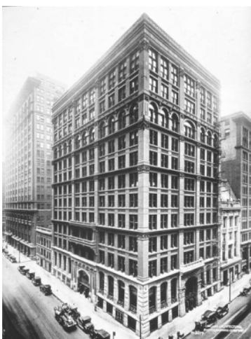
fig.2.3.1f Home Insurance Building , CHICAGO, S.U.A. (1883-1885) - arh.ing. William le Baron Jenney - clădirea care își revendică primatul în utilizarea sistemului constructiv 'zgârie-nor', considerată pasul decisiv în evoluția structurii în cadre de fier și oțel. Întreaga clădire, inclusiv fațadele, descarcă aici pe un schelet metalic format din stâlpi cilindrici din fontă și chesoane din fier forjat și grinzi cu profil I din fier forjat și oțel.
