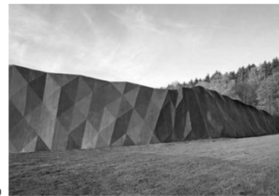
fig.2.6kk Pavilionul de la Hinzert , Germania - arh. Wandel Hoefer Lorch și Hirsch - deși mizează de la început pe imaginea oferită de sistemul portant, forma se supune cerințelor structurale doar în măsura în care acestea impun unghiurile minimale dintre componentele triunghiulare care formează sistemul, astfel încât lucrând împreună ca un continuu să genereze o placă cutată suficient de rigidă.
