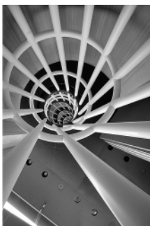
fig.2.6m Sendai Mediatheque , Japonia (1995-2001) - arh. Toyo Ito - structura metalică este invitată să preia în componentele liniare eforturile ce se doreau a fi descărcate, nu în stâlpi, ci în câteva tuburi hiperboloidale care oferă deopotrivă suport, rigidizare și legături spațial-funcționale pe verticală.
