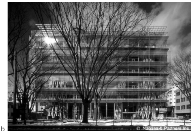
fig.2.6m Sendai Mediatheque , Japonia (1995-2001) - arh. Toyo Ito - structura metalică este invitată să preia în componentele liniare eforturile ce se doreau a fi descărcate, nu în stâlpi, ci în câteva tuburi hiperboloidale care oferă deopotrivă suport, rigidizare și legături spațial-funcționale pe verticală.
