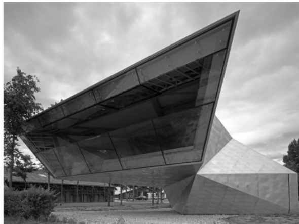
fig.2.6ii Tea House , Olanda (2004-2006) - UN Studio - ciudata apariție, care împachetează un buncăr construit în anii 1936, se bazează pe un schelet din profile HEB. Acesta îi permite, profitând de contragreutatea oferită de masivul de beton, ieșirea în consolă cu 14m.
