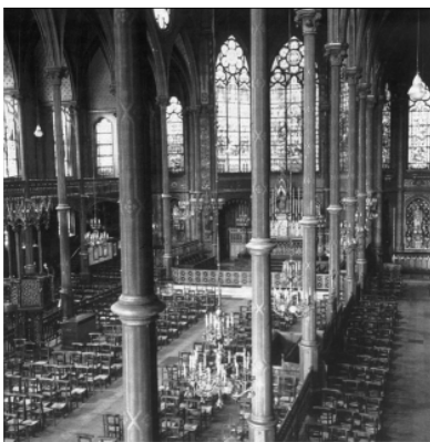
fig.2.2.3j Saint Eugene, PARIS, Franța (1854-1855) - arh. Louis-Auguste Boileau - prima biserică din Paris construită pe o structură aproape în totalitate din fier. Nu oferă forme sau spații ieșite din comun, poate cel mult contradictorii prin dimensiunea neobișnuită a componentelor goticizate.
