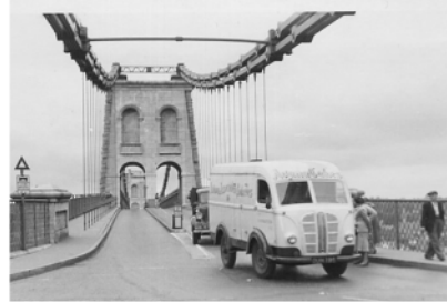
fig.2.2.1a6 Podul Menai , Țara Galilor (1819-1824) - ing. Thomas Telford - principiu de suspendare cu lanțuri metalice, capete de pod tratate în stil Neoclasic.
