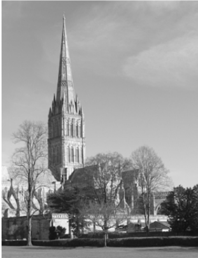
fig.2.1e Catedrala Salisbury , SALISBURY, Anglia (1220-1258) - turnul prezintă o ingenioasă structură compozită cu parament de piatră așezat pe un schelet din lemn legat la bază cu benzi din fier forjat manual.
