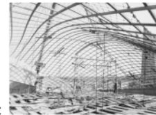
fig. 3.6.5d Olympiapark - formele structurale impuse de liniile de forță, care în asemenea condiții generează nemijlocit imaginea arhitecturală, sunt în mod inedit alăturate în efortul comun de adaptare la teren și protejare a funcțiilor necesare, într-o imagine ce continuă într-o manieră fascinantă formele naturale. Succesul acestor soluții avea să stimuleze industria în dezvoltarea unor noduri speciale din oțel turnat care să permită o creștere a încărcărilor preluate de îmbinări.
