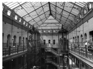
fig.3.6.3d Clădirea Brandbury - cantitatea mare de lumină ce intra prin acoperișul de metal și sticlă, relevă potențialul sistemului structural de a soluționa cerințe inedite.
