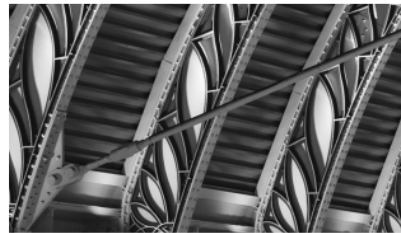
fig.3.6.4b Galeria comercială GUMS - sistemul de arc cu tiranți oblici avea să marcheze un spațiu extrem de interesant. Elementele liniare de mare finețe se pierd pur și simplu în lumina puternică, impresia lăsată fiind aceea a unei uriașe pânze de păianjen
