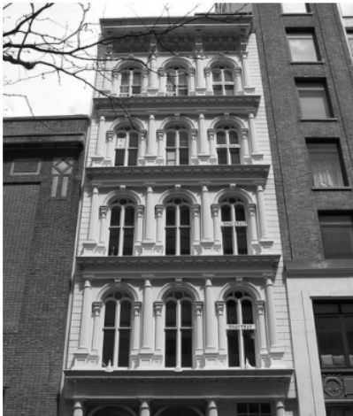
fig.2.2.1g5 Hopkins Store , Murray Street, NEW YORK, S.U.A. (1875) - constr. James Bogardus - soluție ornamentală kitsch, mai ieftină decât piatra, în care proporția elementelor este imitată de coji subțiri turnate din fontă.
