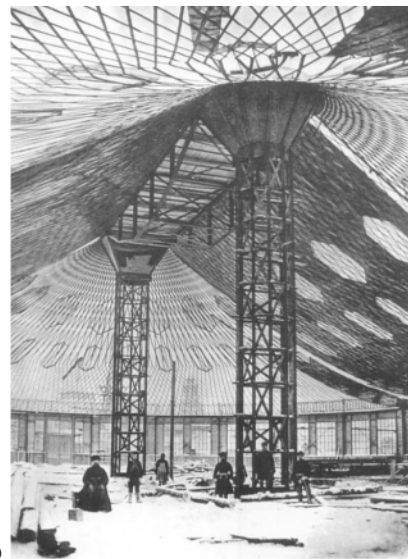
fig.3.6.5a Hala All-Russian Exhibition din 1896 - rețeaua de benzi din fier forjat, întinsă între componentele structurale rigide din centru și cele de pe conturul clădirii, reface la o scară impresionantă spațialitatea cortului de circ.
