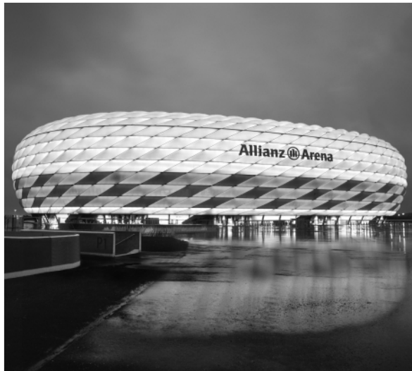
fig.2.6y Allianz Arena , Germania (2000-2005) - arh. Jaques Herzog și Pierre de Meuron - expresia se obține prin intermediul unei anvelopante a cărei rețea romboidală, dictată de rațiuni expresive, împachetează uniform, independent de grila structurală, atât structura de beton a tribunelor cât și cea metalică a sistemului de acoperire.
