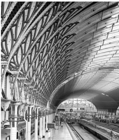
fig.3.6.4a Gara Paddington - exemplul perfect de utilizare a sistemului de acoperire cu arce cu tiranți. Dacă înălțimea necesară trecerii garniturilor de tren era relativ mică, nefiind deranjată de tiranți care leagă capetele arcelor, spațiul împânzit de tiranți se dovedea util evacuării fumului lăsat de locomotivele cu aburi.
