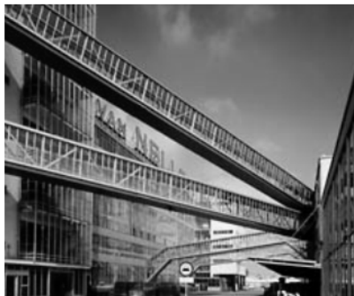
fig.2.4.5c Fabrica Van Nelle , ROTTERDAM, Olanda (1926-1930) - Jan Brinkman și Leen van der Vlugt - unul dintre primele proiecte raționaliste executate. Oțelul are aici rolul de a susține pasarele și benzi transportoare ce rezolvă legătura funcțională dintre cele două clădiri cu structură din beton armat.
