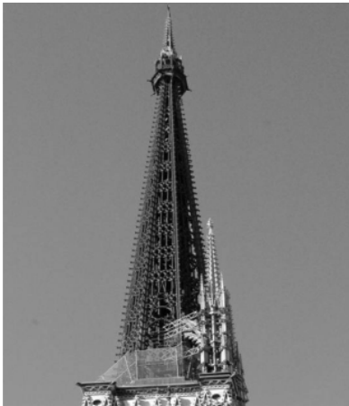
fig.2.2.3i Fleșa Catedralei din Rouen, Franța (1848-1877) - Jean-Antoine Alavoine și finalizată de E. Barthelemy și L. F. Desmarest - o fascinantă structură din fontă, complet deschisă, un exemplu impresionant prin dimensiunile care o plasează între cele mai înalte turlă din Franța 151m.
