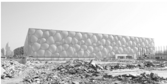
fig.2.6gg National Aquatics Center , China (2003-2008) - PTW Architects & Arup - rețeaua structurală, ce are la bază subdiviziunea spațială Weaire-Phelan, generează împreună cu închiderile din ETFE imaginea aparent aleatorie a unui uriaș cub din bule de săpun.
