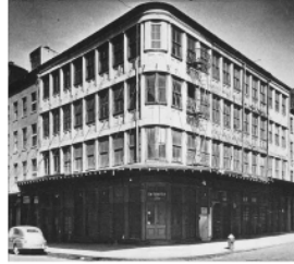
fig.2.2.1g4 Harper's Bilding , NEW YORK, S.U.A. (1854) - arh. John B.Corlies - exemplu relevant de ornamentație kitsch în stil renaștere târzie, încorporează primele grinzi din oțel laminat.
