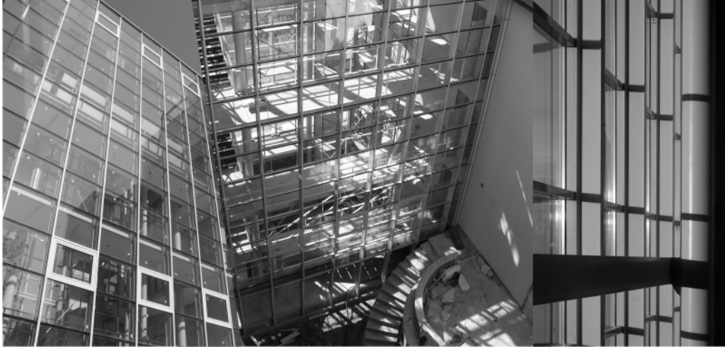
fig.7.4.6b Hol 'atrium' - montanți de fațadă cu rol portant (foto Hârța, Ovidiu Micșa)
