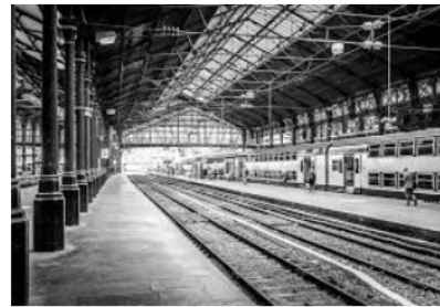
fig.3.6.3b Gara St.Lazare - sistemul structural cu ferme Polonceau, ce preiau acoperirea peroanelor pe o deschidere de 40m, relevă unul dintre primele spații protejate de o asemenea scară.
