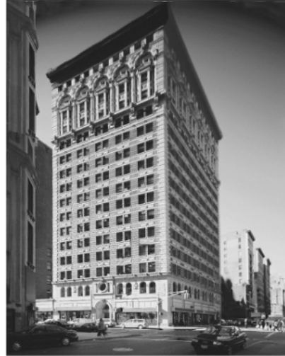
fig.2.3.1m St James Building , NEW YORK, S.U.A. (1897-1898) - arh. Bruce Price - exemplu caracteristic de sistem structural 'zgârie nori' împachetat în ornament istorist.
