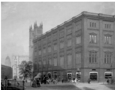
fig.2.2.2j Bauakademie , BERLIN, Germania (1831-1836) - arh. Kark Fridrich Schinkel - remarcabilă pentru abordarea inovativă, aproape complet lipsită de ornament aplicat, îngloba grinzi de fier pe care sprijineau bolțișoare de cărămidă. Acest sistem portant cu grinzi de fier descărcate pe pile de zidărie este considerat unul din premergătorii sistemului structural scheletal.
