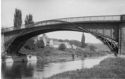
fig.2.2.1a2 Podul Buildwas , Anglia (1796) - ing. Thomas Telford - o interesantă structură din fontă cu arce suprapuse dovedește, pe de o parte, necunoașterea deplină a caracteristicilor noului material, pe de alta, creșterea încrederii în potențialul acestuia.
