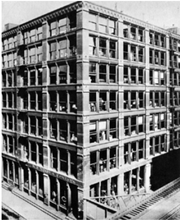
fig.2.3.1d Leiter Building , CHICAGO, S.U.A. (1879) - arh.ing. William le Baron Jenney folosește o structură scheletală ce poate fi considerată independentă. Greutatea celor cinci planșee, aici pe grinzi de lemn, era preluată în totalitate pe stâlpi de fontă, pilele de zidărie ale fațadei având doar rol autoportant.
