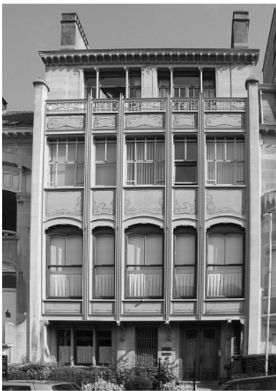
fig.2.3.2d Casa Van Eetvelde , BRUXELLES, Belgia (1895) - arh. Victor Horta - fațada, de un stil aproape Sullivanian, exprimă sistemul de închidere compus din casete de fier forjat fixate între arcade de fontă aparente. Salonul reprezintă o capodoperă ce depășește poate casa de scară a casei Tassel.
