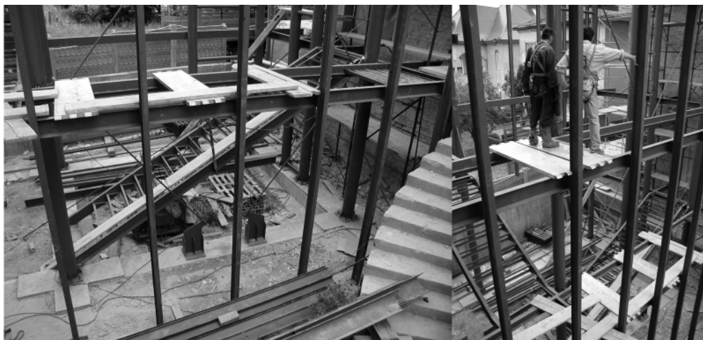
fig.7.4.6a Hol 'atrium' - montanș de fațadă cu rol portant - șantier (foto Hârța)
