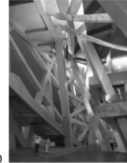
fig.2.6gg National Aquatics Center , China (2003-2008) - PTW Architects & Arup - rețeaua structurală, ce are la bază subdiviziunea spațială Weaire-Phelan, generează împreună cu închiderile din ETFE imaginea aparent aleatorie a unui uriaș cub din bule de săpun.
