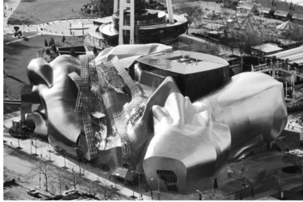
fig.2.6k Experience Music Project , USA (1995-2000) - arh. Frank Gehry - proiectată de inginerii de la Magnusson Klemencic Associates, această soluție structurală cu componente unicat de forme extrem de complexe, a devenit posibilă datorită avansului în tehnologia CAD/CAM.
