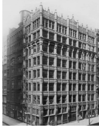
fig.2.3.1k Tower Building , NEW YORK, S.U.A. (1888-1889) - prima clădire construită pe noul sistem la New York, soluția fiind impusă de amplasamentul extrem de îngust pe care o variantă cu fațadă de zidărie nu era fezabilă. Ornamentul rămâne aici istorist.
