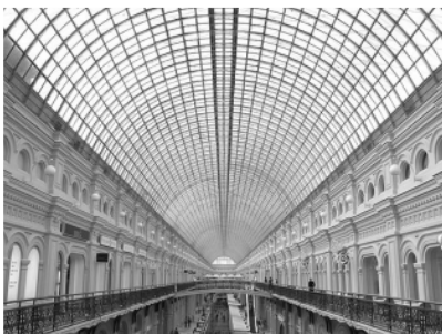
fig.3.6.4b Galeria comercială GUMS - sistemul de arc cu tiranți oblici avea să marcheze un spațiu extrem de interesant. Elementele liniare de mare finețe se pierd pur și simplu în lumina puternică, impresia lăsată fiind aceea a unei uriașe pânze de păianjen
