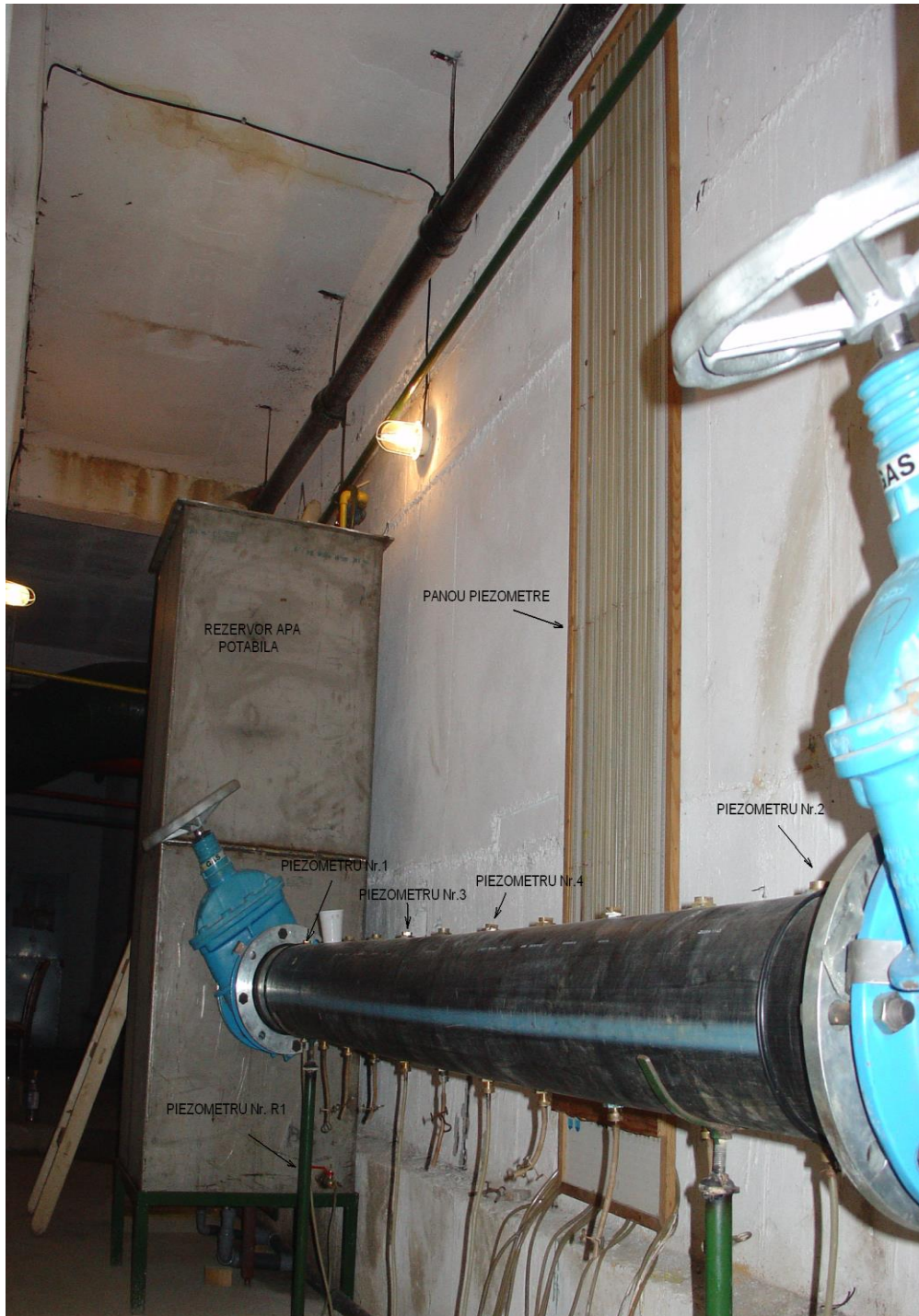
Fig.6.15. Vedere de ansamblu cu identificarea și poziționarea piezometrelor
