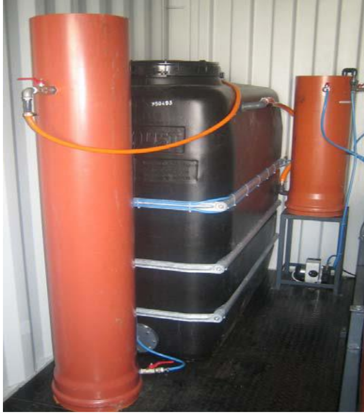
Fig. 5.13. Rezervor pentru acumularea apei brute [21],[83]
