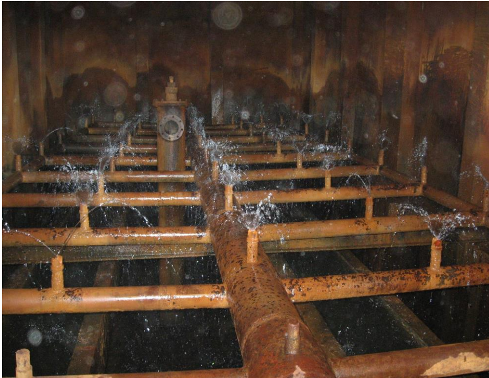
Fig.3.6. Vedere de ansamblu asupra unei camere de deferizare prin aerul atmosferic
