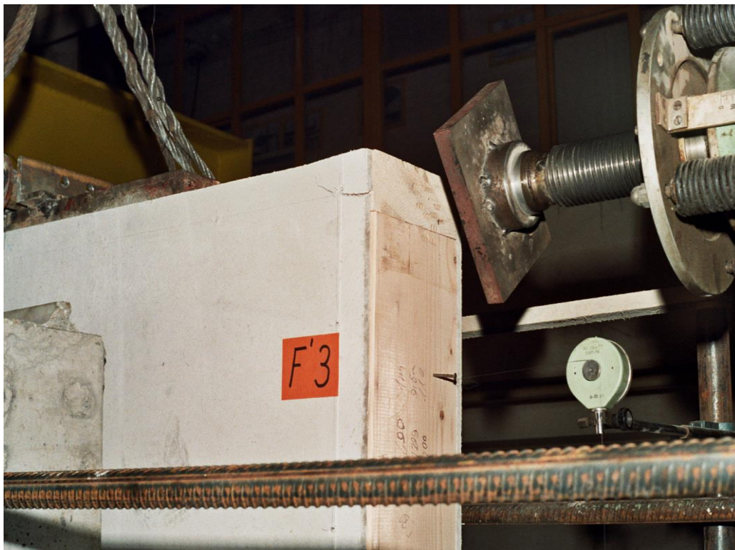
Fig.8.8 – Apariția primei fisuri în placa Vidiwall în colțul din dreapta sus
