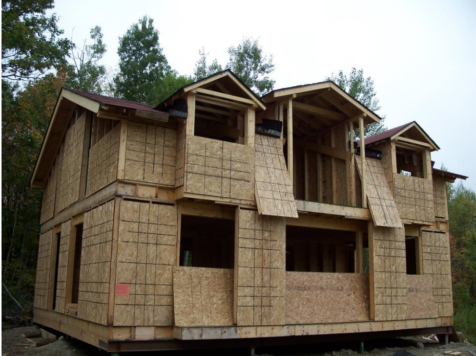
Fig.1.14 – Structură, cu pereți și planșee din lemn pentru locuință unifamilială. proiectată și executată de autor
