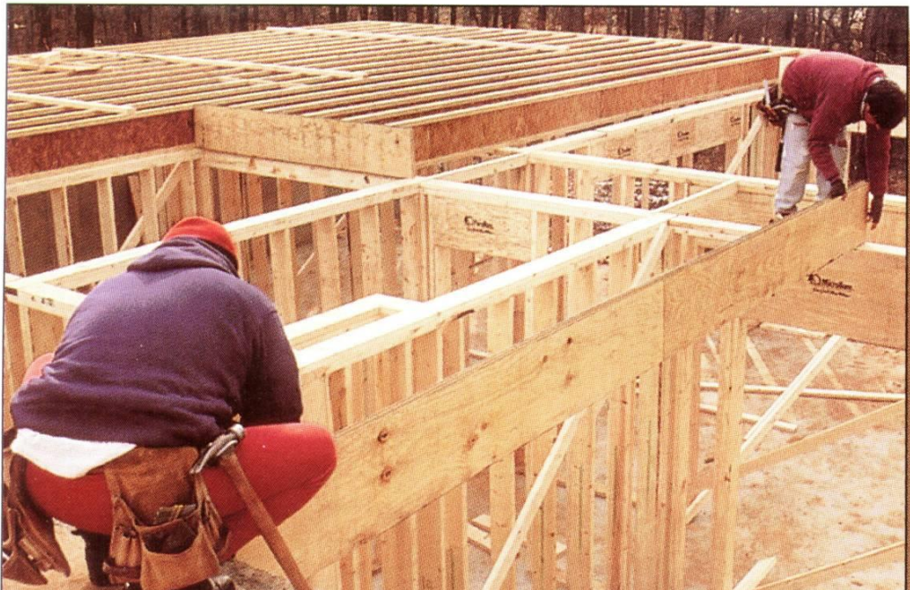
Fig.1.22 - Execuția planșului unei construcții cu structură din lemn, utilizând elemente de tip Microllam.
