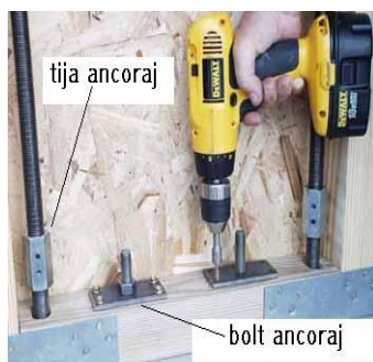
Fig. 5.18 – Fixarea piulițelor de cuplare
