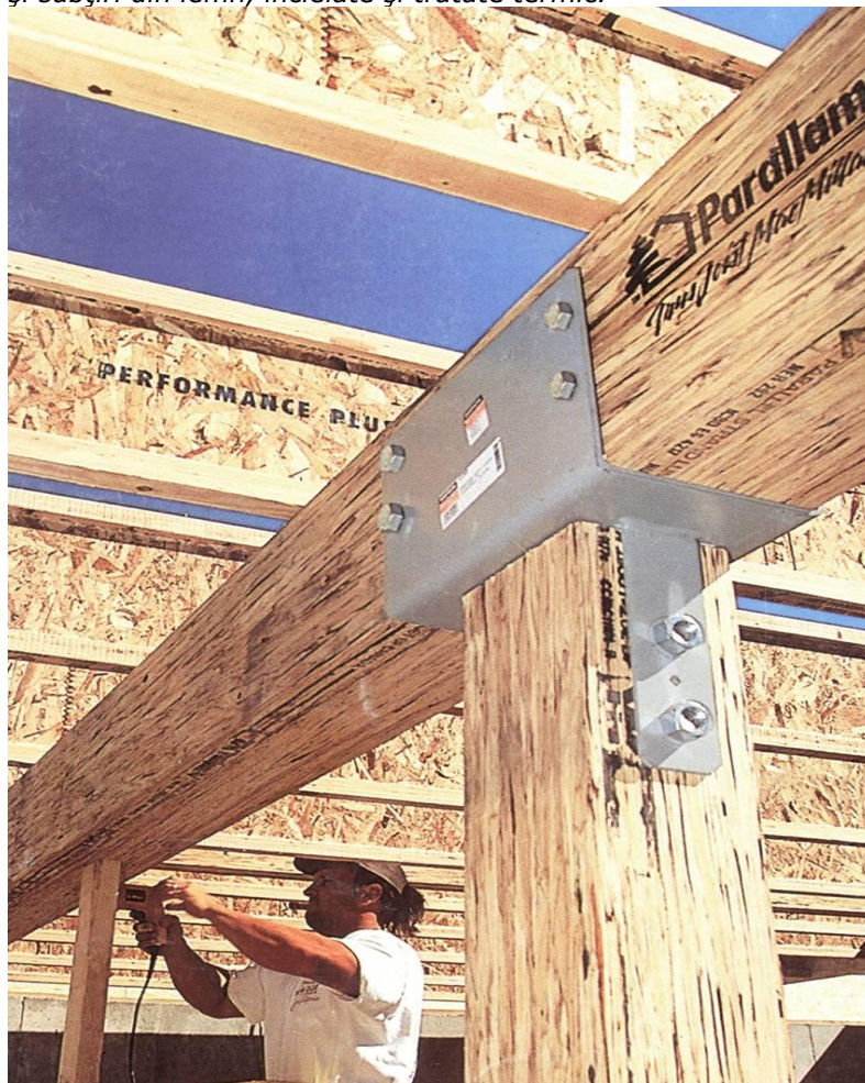
Fig. 1.20 – Stâlp și grindă din parallam care susțin un planșeu..
