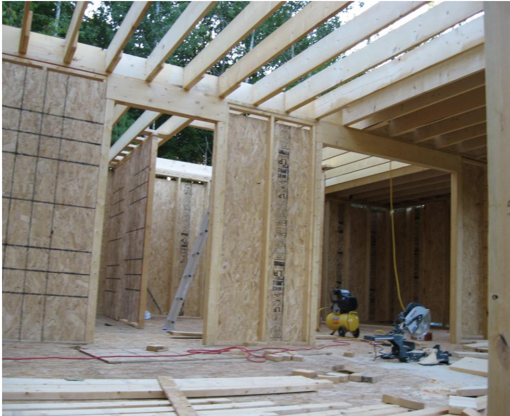
Fig. 5.10 - Imagine din timpul construcției unei locuințe uni-familiale proiectată și executată de autor; panourile de pereți sunt asamblate pe șantier (foto D. Mihai)
