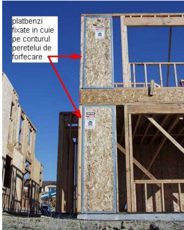
Fig.5.6 Fixarea în cuie a plăcilor de OSB pe montanți prin intermediul platbenzilor
