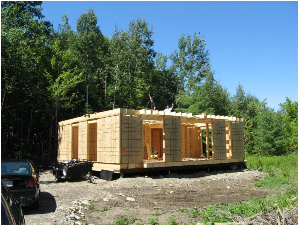
Fig.5.4. Structură din lemn executată de autor; lățimea minimă a panourilor de perete este egală cu jumătatea înălțimii. (Foto D. Mihai)
