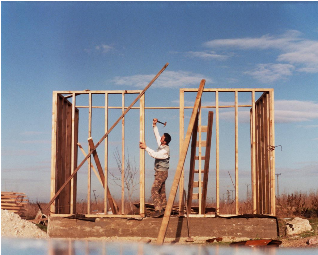
Fig. 9.1 – Imagine din timpul asamblării pereților la o locuință unifamilială situată în Moșnița Nouă, jud. Timiș, proiectată și executată de autor ( 2001).
