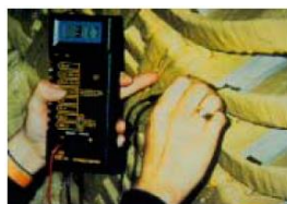
Figura 8.5. Măsurarea capacității bobinelor stator
