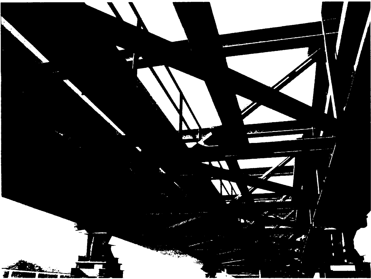
Fig. 2.30. Transversal stiffeners
