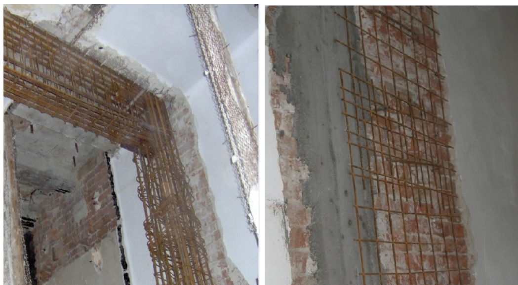
Fig. 5.11. Armarea cadrului de consolidare
