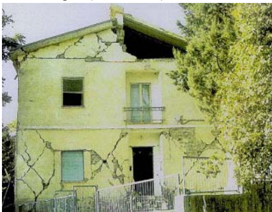
Fig. 4.15. Colapsul frontonului [2]
