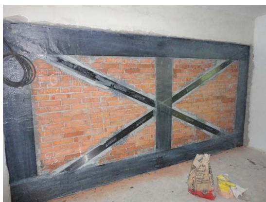
Fig. 6.10. Consolidarea cu pânze și lamele de carbon a pereților despărțitori din zidărie de cărămidă
