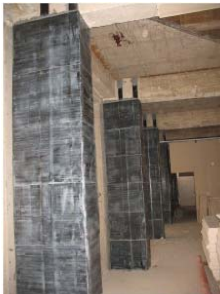
Fig. 6.8 Cosolidarea stâlpilor cu pânze de carbon
