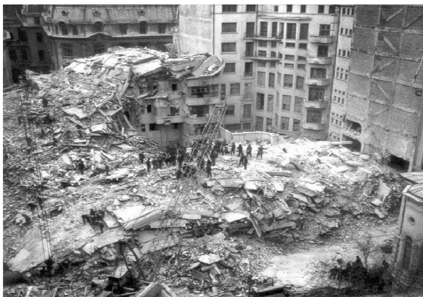
Fig. 2.10. Clădiri prăbușite în București în urma cutremurului din 4 martie 1977
