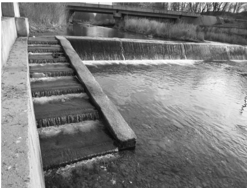
Fig. 4.1. Pasaj pentru pești la pragul de fund pe râul Porumbacu, Porumbacu de Jos, România. Foto: P. Molnar.
