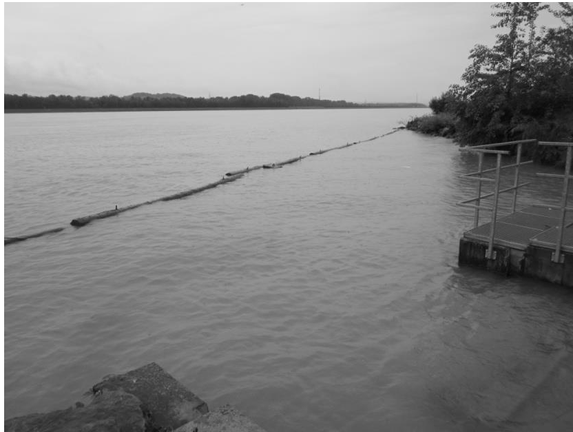
Figura 4.34. Flotare pentru protecția împotriva materialelor plutitoare la pasajul pentru pești pe Dunăre la Melk, Austria. Foto: P. Molnar.
