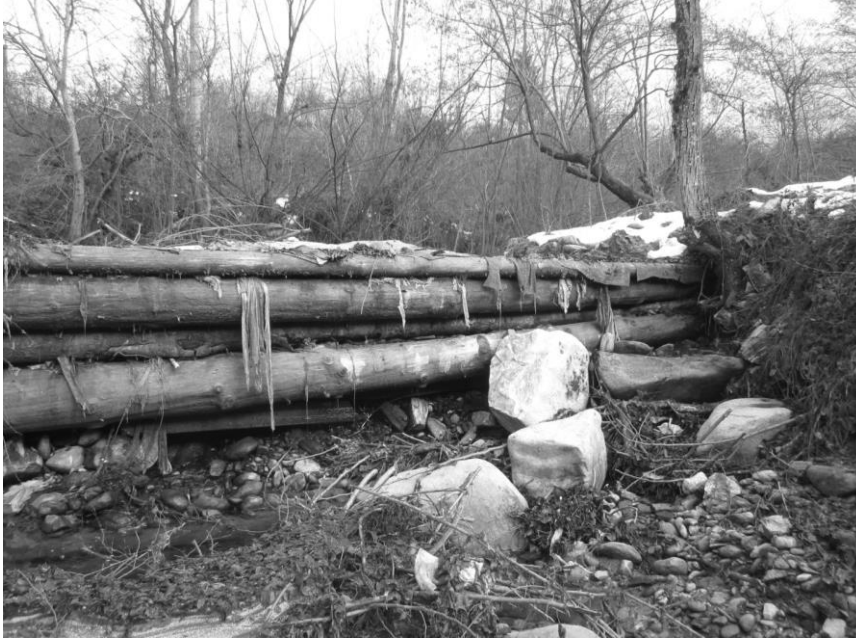
Figura 6.8. Barare la confluența Sebeșel – Sebeș pentru priza de apă gater, vedere din aval. 06.01.2013. Foto: P. Molnar.
