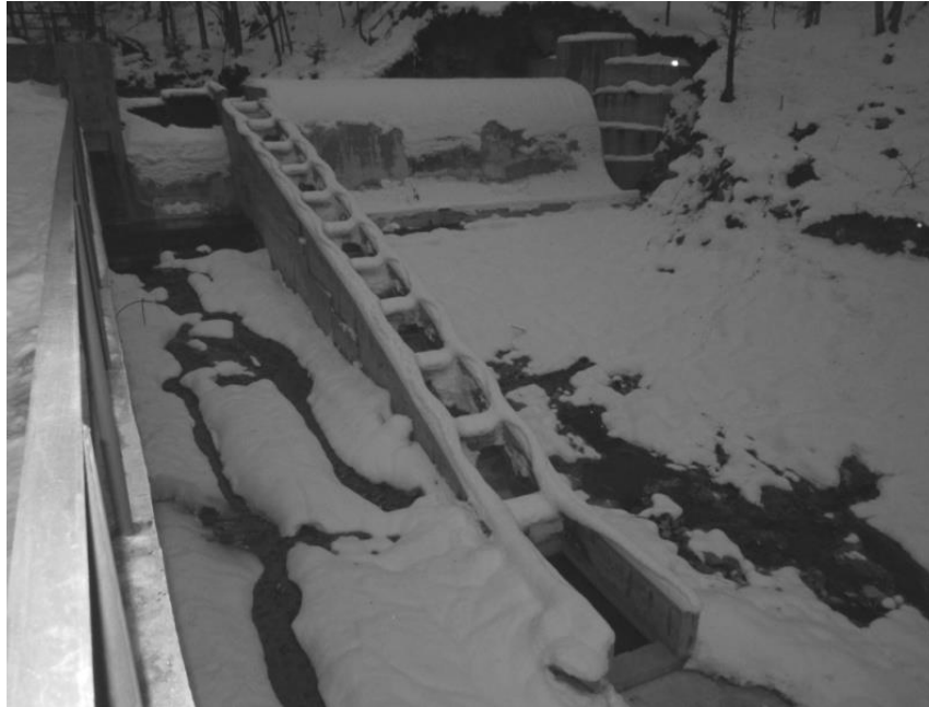
Figura 6.18. Pasajul pentru migrația faunei acvatice la captarea secundară Cuntu, 22.12.2012. Foto: P. Molnar.
