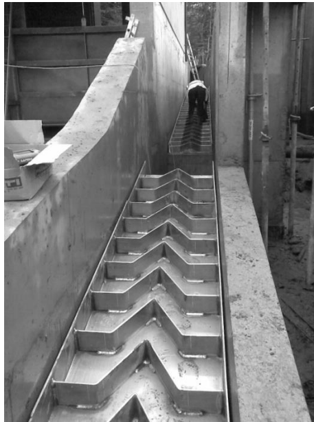
Fig. 4.8. Element prefabricat pentru pasaj de tip Larinier, în curs de montare. Sursa: http://eoevolution.ie/ .
