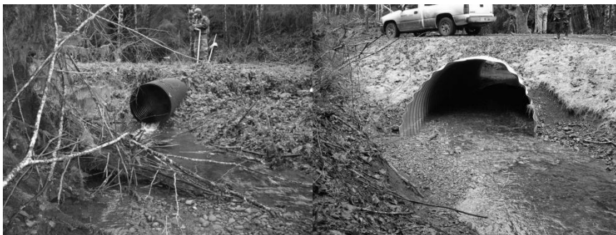
Figura 4.17. Două exemple de podețe tubulare: în stânga lipsește legătura cu albia râului; podețul din dreapta este corect realizat, cu substrat natural și cu minime influențe asupra curgerii. Sursa: http://washingtondnr.files.wordpress.com .
