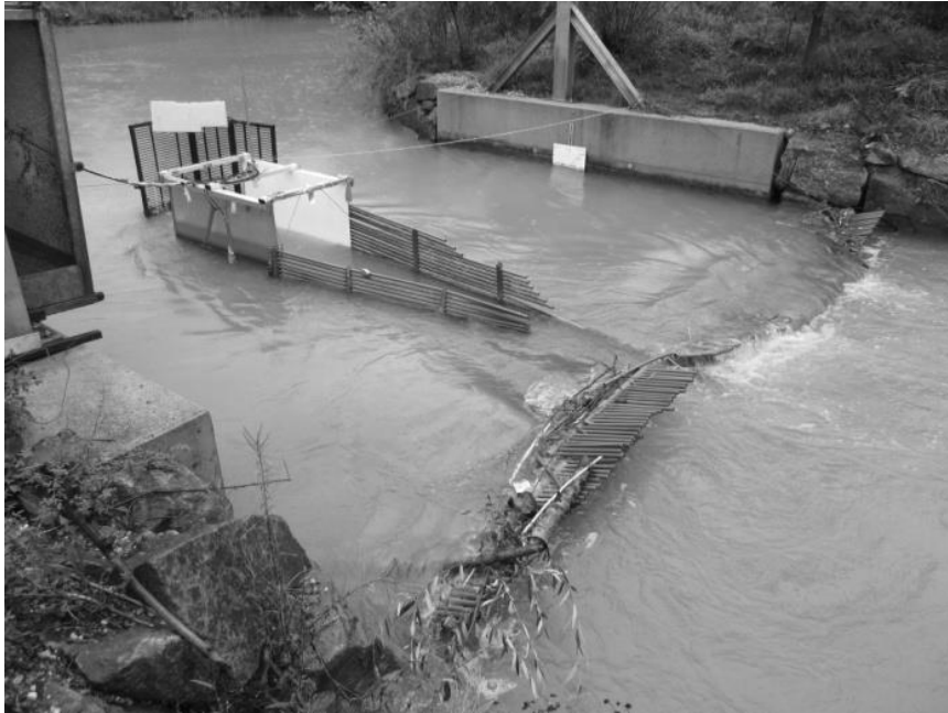
Figura 4.33. Improvizație datorită planificării deficiente a monitorizării la instalația pentru monitorizarea peștilor în pasajul de la Melk pe Dunăre/Austria. Foto: P. Molnar.
