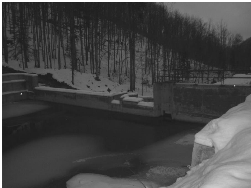
Figura 6.19. Poziționarea batardourilor pentru priza de fund, respectiv pentru scara de pești. 22.12.2012. Foto: Paul Molnar.
