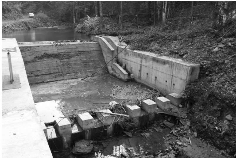
Figura 6.3. Captarea pentru MHC Cuntu, prevăzută cu "scară de pești" pe malul stâng. 21.10.2012. Foto: P. Molnar.
