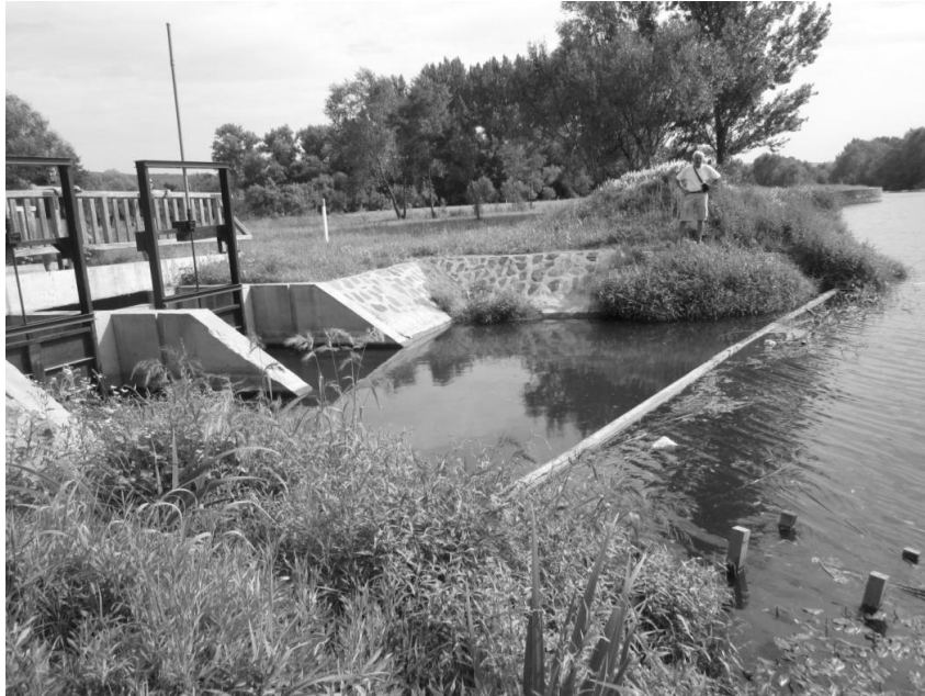
Fig.4.5. Stăvilare și flotor pentru protecția împotriva materialelor plutitoare la alimentarea pasajului cvasi-natural pe râul Ipoly în Ungaria. Foto: P. Molnar.
