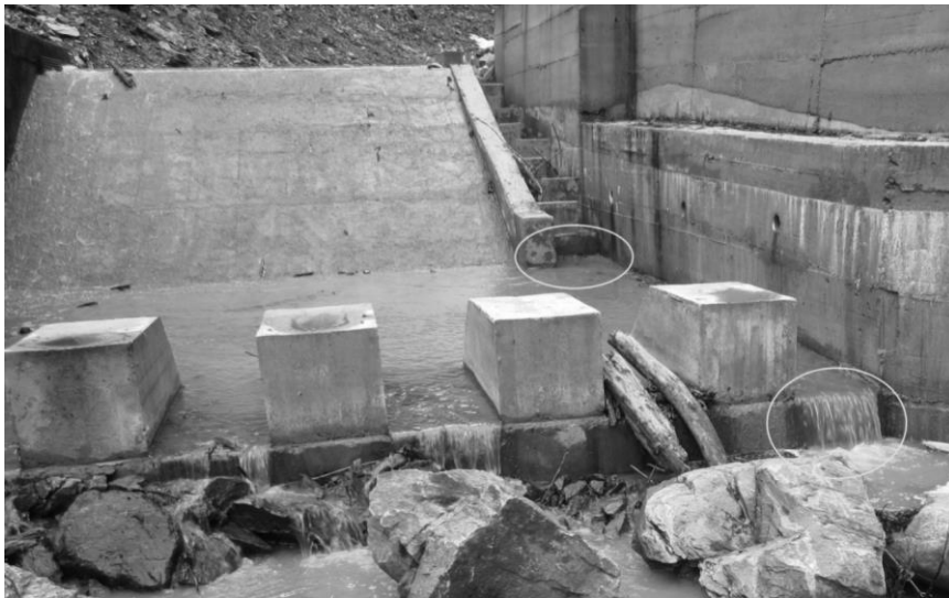
Figura 6.16. Captarea Craiu 1, pasajul pentru pești și disipatorul de energie. „Scara de pești” nu este racordată la albia râului, iar disipatorul de energie formează o cădere suplimentară. 21.04.2012. Foto: P. Molnar.
