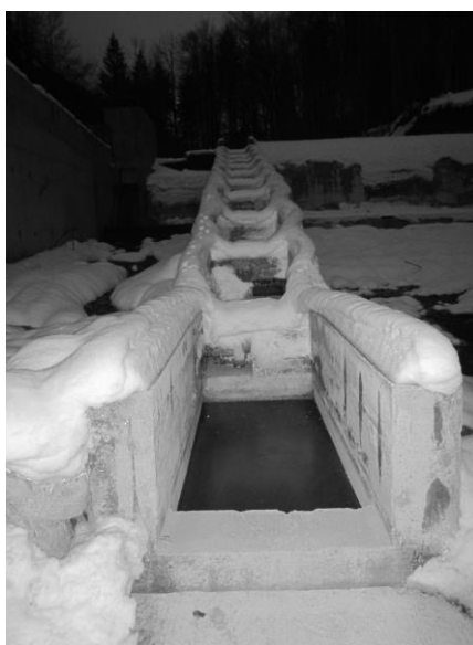
Figura 6.20. Captarea Cuntu, lipsa debitului de servitute și a debitului pentru funcționarea scării de pești, 22.12.2013. Foto: P. Molnar.
