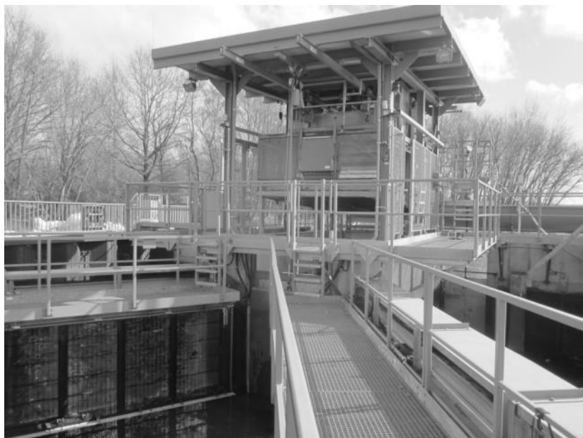
Figura 4.29. Instalația pentru monitorizarea faunei din pasajul Geesthacht Nord, râul Elbe, în poziția de golire. Foto: P. Molnar.
