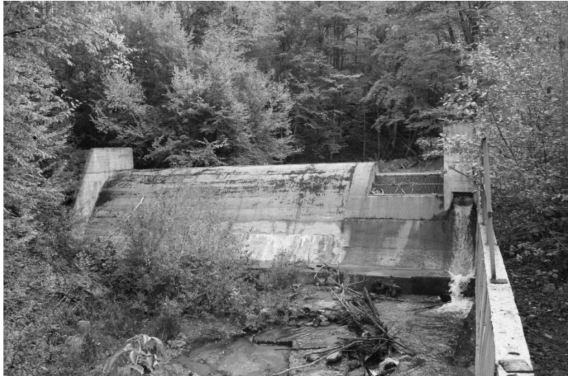
Figura 6.5. Captarea Sebeșel 1 (neutilizată la data respectivă) "AHE Bistra-Poiana Marului-Ruieni-Poiana Rusca" fără pasaj pentru migrația faunei acvatice. 25.10.2012. Foto: P. Molnar.
