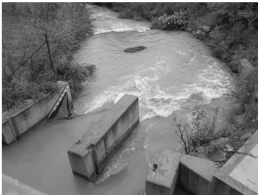
Fig. 4.6. Pasaj cvasi-natural pe fluviul Dunărea la Melk/Austria, control al debitului în pasaj printr-un deversor gonflabil cu comandă automată. Foto: P. Molnar.
