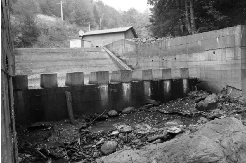
Figura 6.17. Captarea Craiu 2, disipatorul de energie – obstacol în calea migrării, debitul de servitute lipsește, 25.10.2012. Foto: P. Molnar.
