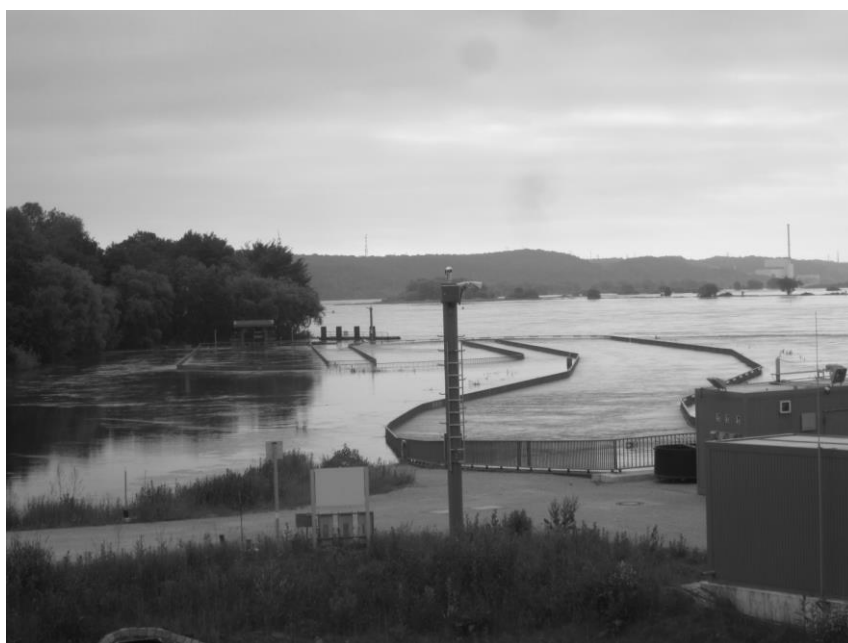
Figura 4.32. Pasajul Geesthacht Nord în timpul inundațiilor din 2013. Foto: P. Molnar.
