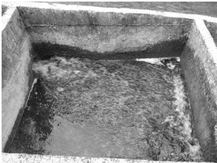
Figura 4.12. Pasaj cu bazine și cu orificii pe râul Miniș la Gura Golâmbului; detaliu: bazin și orificiu submers între bazine (stânga sus). Deoarece pasajul tranzitează numai debitul de servitute, nivelul apei este foarte scăzut: 0.03 – 0.05 m. Foto: P. Molnar.
