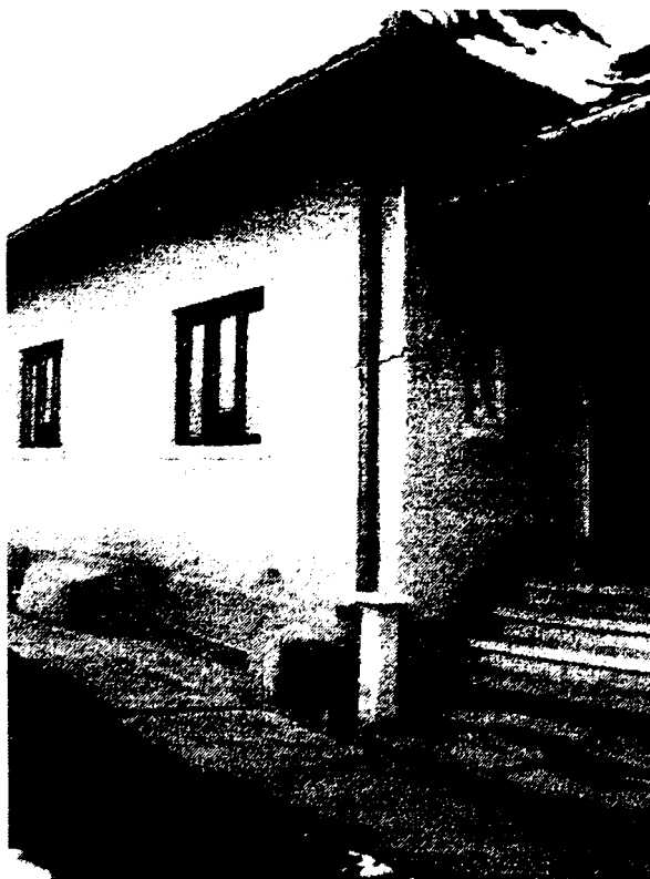
Fig. 1.10.2.4. a) Imagini cu fisuri si dislocari ale zidurilor portante, datorate alunecarilor de teren in Comuna Rosia de Amaradia, Judetul Gorj
