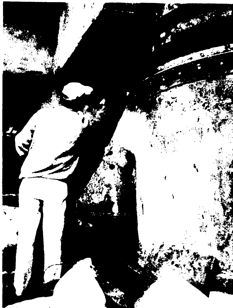
Fig. 4.16.6. Curatirea prin mijloacele manuale a straturilor afectate de actiunea ureei, in vederea aplicarii tratamentelor corespunzatoare.
