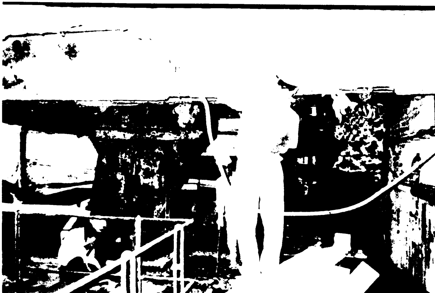
Fig. 4.16.7. Curatirea prin mijloace manuale a straturilor afectate de actiunea ureei, in vederea aplicarii tratamentelor corespunzatoare.
