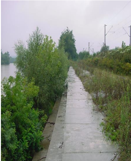
Fig. 5.13 Apărare la râul Mureș, în dreptul localității Vărădia km.558+700
