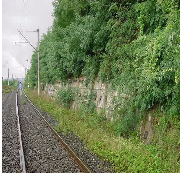
Fig. 6.4 Lucrare de consolidare cu plăci pref. ancorate la km.512+550
