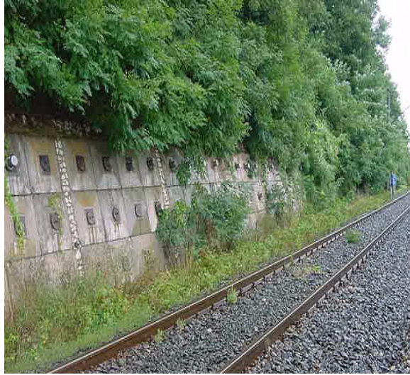
Fig. 6.2 Lucrare de consolidare cu plăci pref. ancorate la km.512+550
