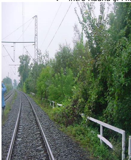
Fig. 5.17 Apărare la râul Mureș, cu prefabricate de beton km.598+800
