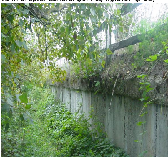
Fig. 5.18 Lucrare de apărare cu prefabricate tip L la km.598+700
