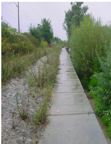
Fig. 5.15 Apărare la râul Mureș, cu blocuri de beton și periu km.558+800
