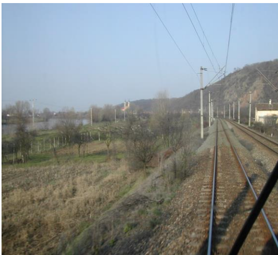
Fig. 5.8 Zonă inundabilă km.551+600
