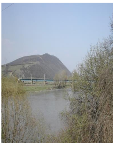
Fig. 5.7 Zonă inundabilă km.493+900
