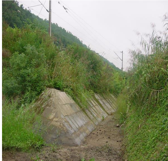
Fig. 6.6 Lucrare de consolidare cu șanț de retenție și scurgere de la km.574+200 la km.574+600
