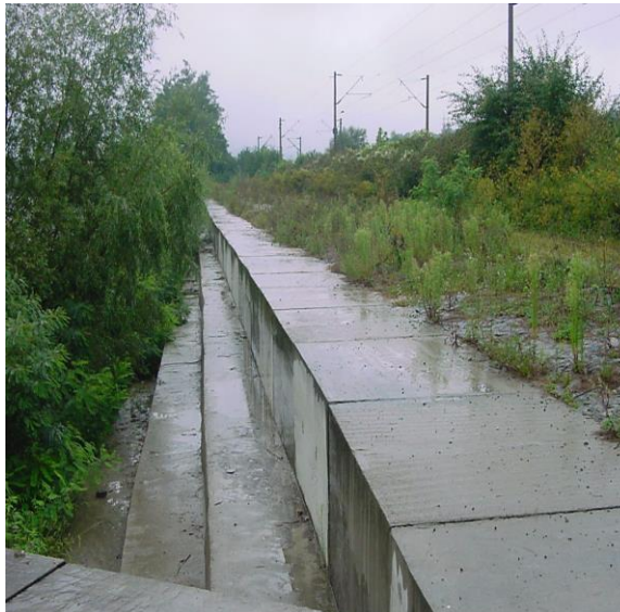
Fig. 5.16 Lucrare de apărare cu pineni și gabioane km.558+700
