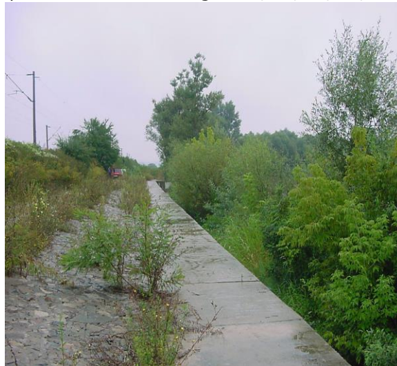
Fig. 5.14 Lucrare de apărare a terasamentului CF la km.558+800
