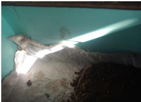
Fig. 6.24 Detaliu așezare polistiren extrudat
