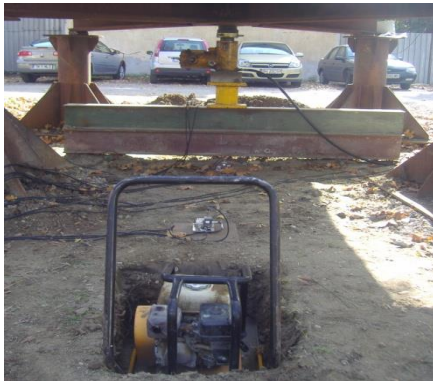
Fig. 6.73 Placă vibrantă
