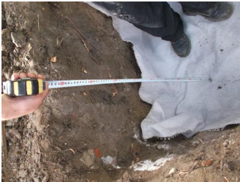
Fig.6.65 Dispunere geotextil tip PEC 55/50/F
