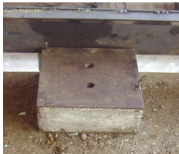
Fig. 6.22 Fundație de beton
