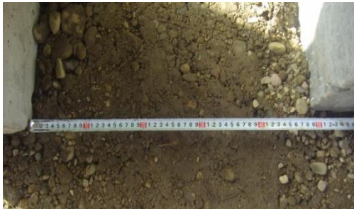
Fig. 6.3 Distanța între fundații – direcție transversală
