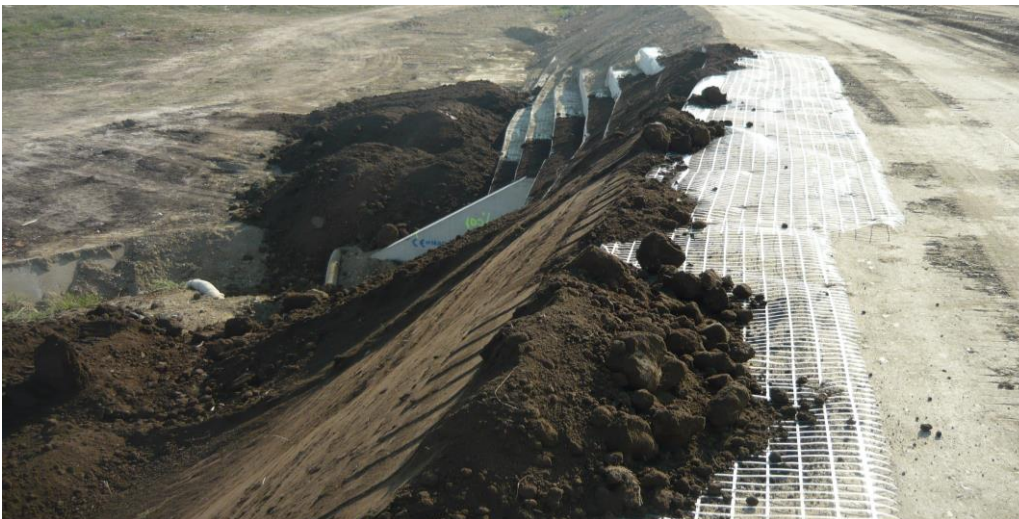
Fig. 2.35 Zid de sprijin realizat cu geogrile [90]
