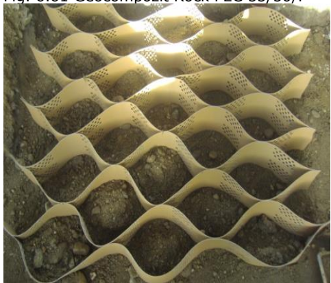
Fig. 6.63 Geocelulă cu înălțime și alveole mari tip PRS 660
