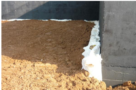
Fig. 2.5 Utilizarea geosinteticelor cu rol de separare
