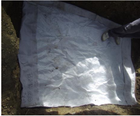
Fig. 6.7 Dispunere geosintetic de separare
