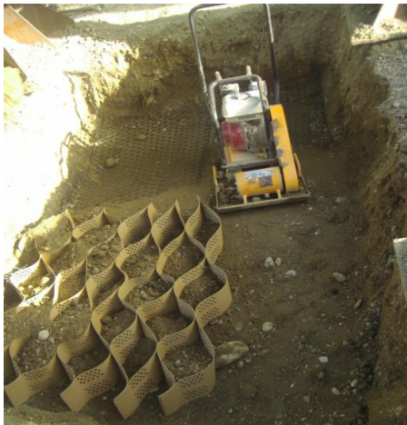
Fig. 6.9 Dispunere mat. geosintetice cota -0,55 m
