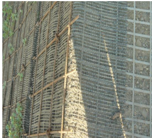
Fig.1.3. Zid de sprijin armătură-geogrilă [86]
