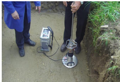
Fig. 6.12 Verificare grad de compactare
