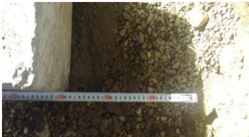
Fig. 6.5 Distanța laterală fundație-săpătură
