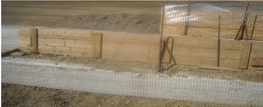
Fig. 2.36 Zid de sprijin realizat cu geogridurile și geotextilele [90]
