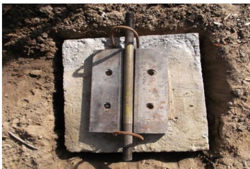
Fig. 6.68 – Așezare fundație în argilă
