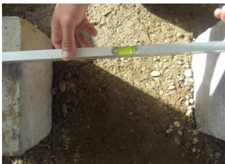
Fig. 6.11 Verificare planeitate
