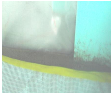
Fig. 6.30 - Așezare geotextil Rock Pec 50/55
