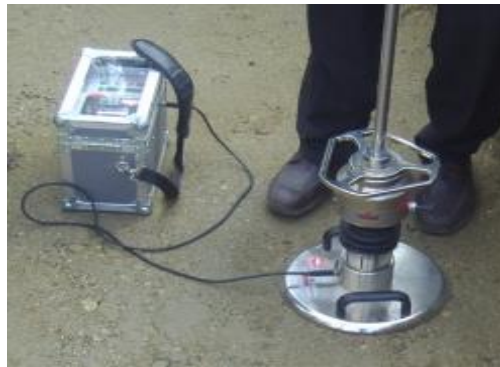
Fig. 6.66 Verificarea grad de compactare
