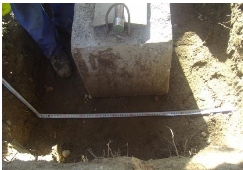
Fig. 6.67 – Așezare fundație în balast
