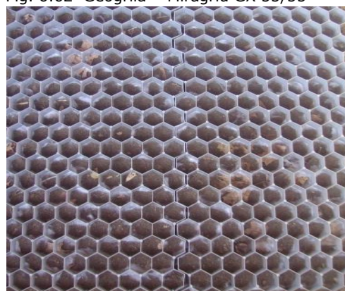
Fig. 6.64 Geocelule cu înălțime și alveole mici tip "fagure"
