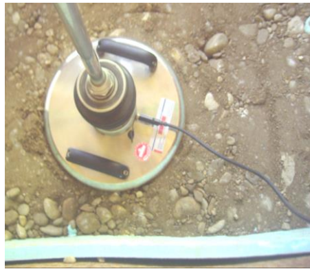
Fig. 6.32 Verificare grad de compactare
