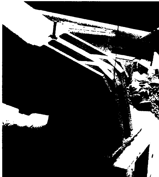
Figura 4-4: Articulație la baza stâlpului
