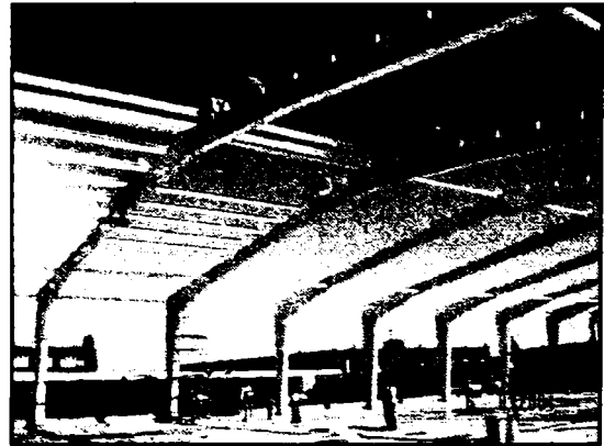
b) montaj structură secundară
