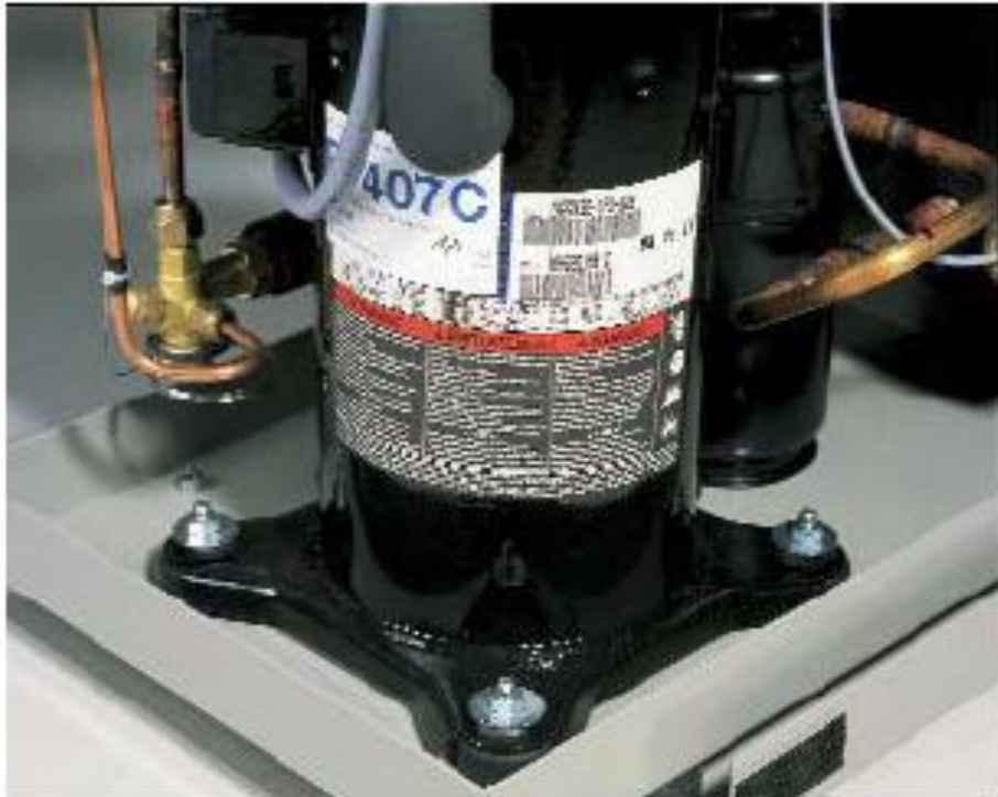
Figura 5.11 Compresorul pompei de căldură OCHSNER [40]
