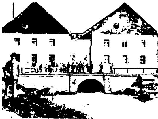
Fig. 3.26. Podul boltit din zidărie de la Moara din Fabric.
