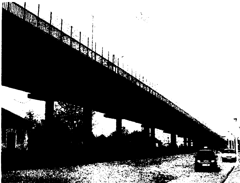
Fig. 1.54. Pasajul de la Caransebeș-Balta Sărată. Vedere de ansamblu.
