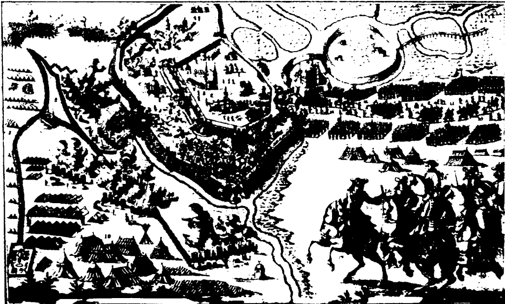
Fig. 3.6. Eliberarea orașului de sub stăpânirea turcească reprezentată în "Hungarische und Venetianische Kriegs Theatrum" de Johan Theodoro Boetio, Leipzig, 1717. Se poate observa un pod lung peste mlaștină.
