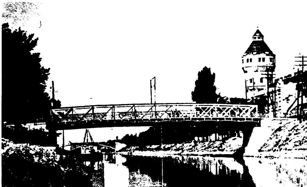
Fig. 3.46. Podul Muncii (fost Regal) înainte de demolare.
