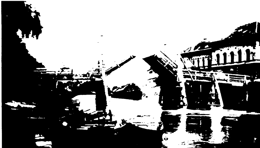
Fig. 1.7. Pod basculant de lemn peste Canalul Bega la Becicherecul Mare, înainte de anul 1904.
