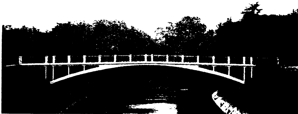
Fig. 4.2. Pasarela dintre parcuri. Fotografie executată de către proiectant.
