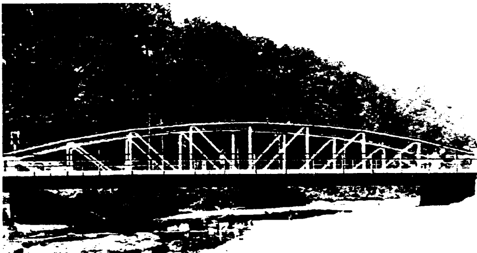
Fig. 1.33. Primul pod integral sudat, din România. Construit la Reșița, peste Bârzava, în anul 1931 (Lungime: 31,42 metri).
