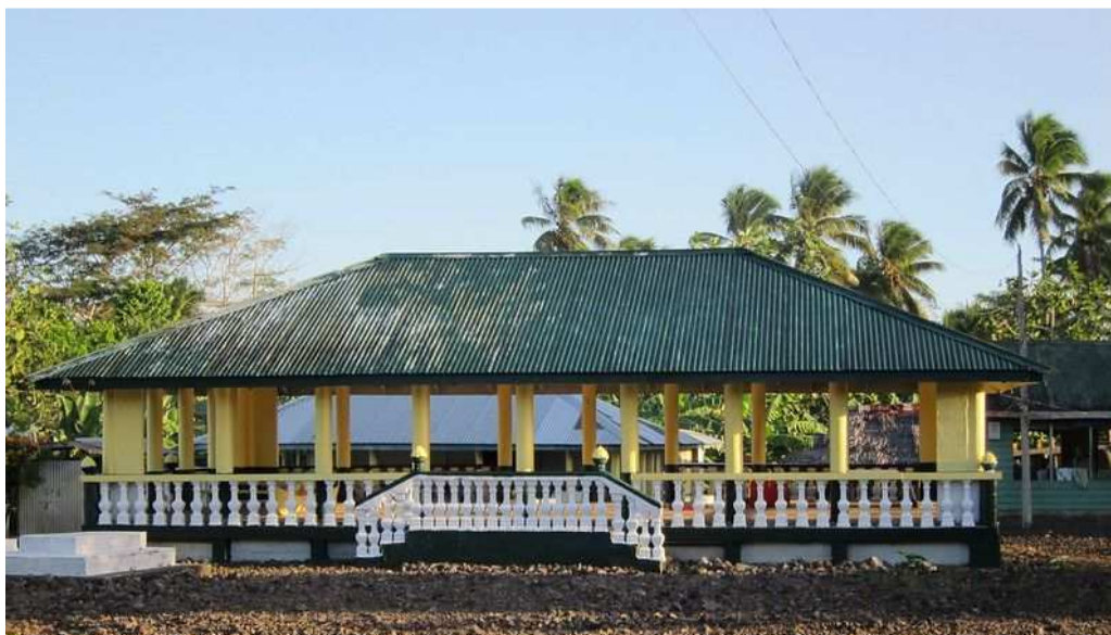
fig. 3.18. Fale afolau (casa lungă) din materiale industriale. Tuamasaga, Samoa (2011) Foto: © jdf_92 (via Flickr)
