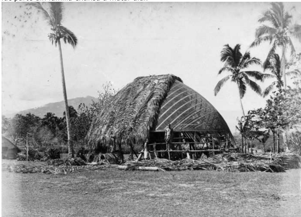
fig. 3.15. O fale tele , în timpul construirii, Apia, Samoa foto: John Davis (1880-1893)
