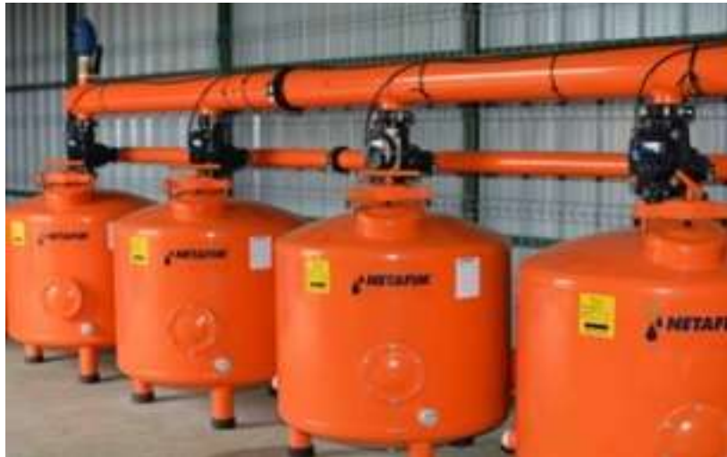
Figura 74 Unitate de filtrare sistem de irigații prin picurare [126]
