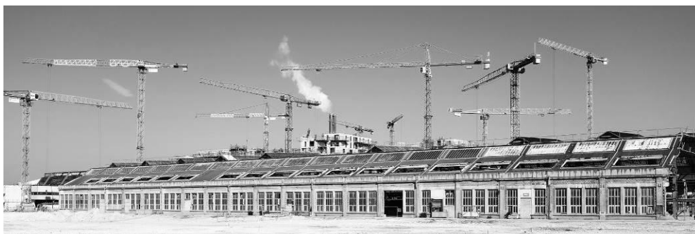
Figura 4.18 Situația existentă a halei Alstom, înainte de intervenție
