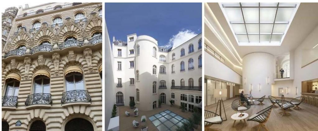
Figura 6.27 Detalii arhitecturale ale clădirii: a) fațada principală, b) proiectul de renovare: curte interioară, atrium și luminator zenital
