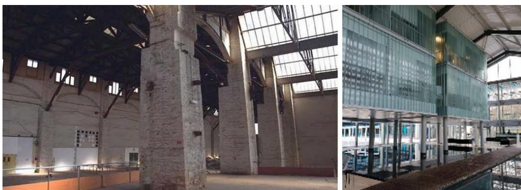
Figura 6.29 a) Situația înainte demolării b) noua construcție
