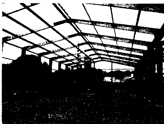
Figura 2.26: Structura tip Frisomat și Galcorom
