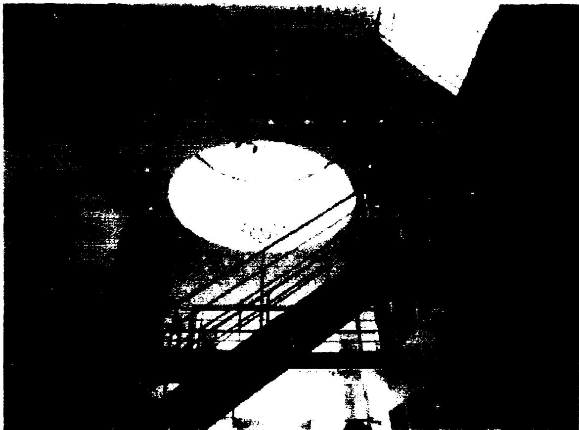
Foto 1.15. Forme realizate cu ajutorul gips cartonului
