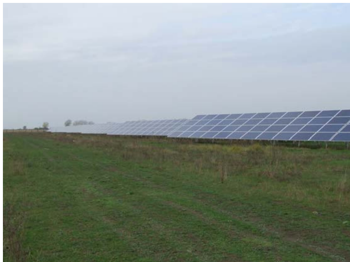
Fig.5.2. Zona A de panouri fotovoltaice
