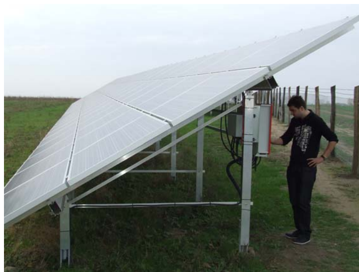
Fig.5.3. Zona B de panouri fotovoltaice
