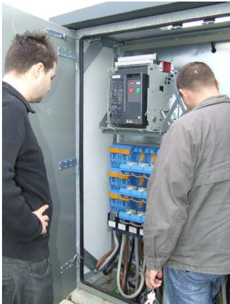
Fig.5.18. Întreruptorul debrășabil Q0. Dimensiuni și amplasare
