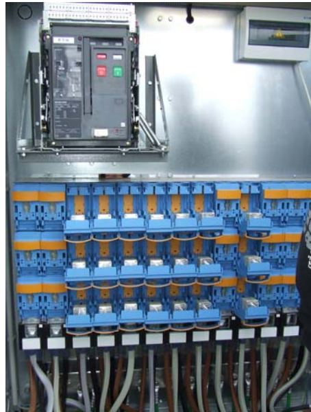
Fig.5.18. Întreruptorul debrășabil Q0. Dimensiuni și amplasare
