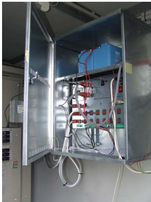
Fig.6.7. Conexiunile la PMU (cablaj parțial)
