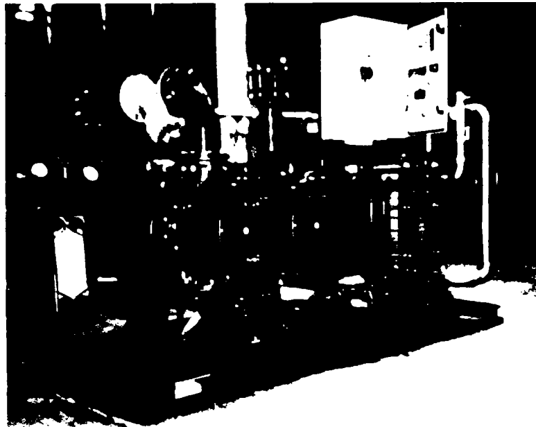
Figura 3.8. Modul de punct termic S-H DHW pentru încălzire și preparare a apei calde menajere
