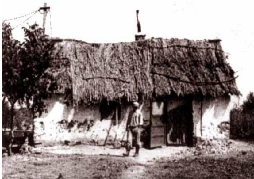
Figura 4.1. Casa construita din lemn și pământ din 1724 [27]
