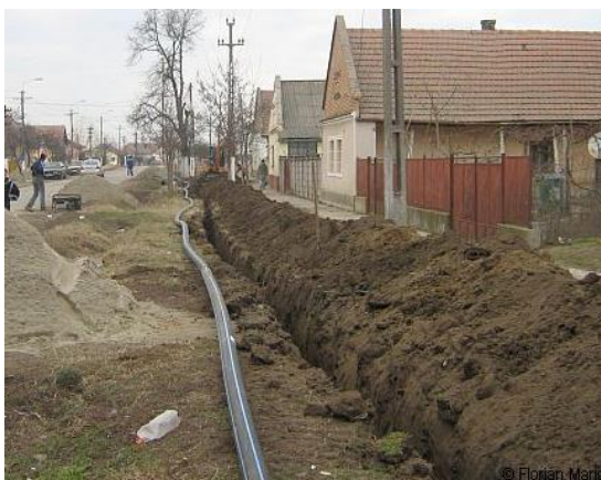
Figura 4.13 Extinderea și reabilitarea rețelei de alimentare cu apă potabilă în comuna Periam (foto STANA O. – 27.05.2011)
