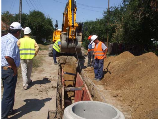
Fig. 1.1 Execuție sistem de canalizare gravitațională
