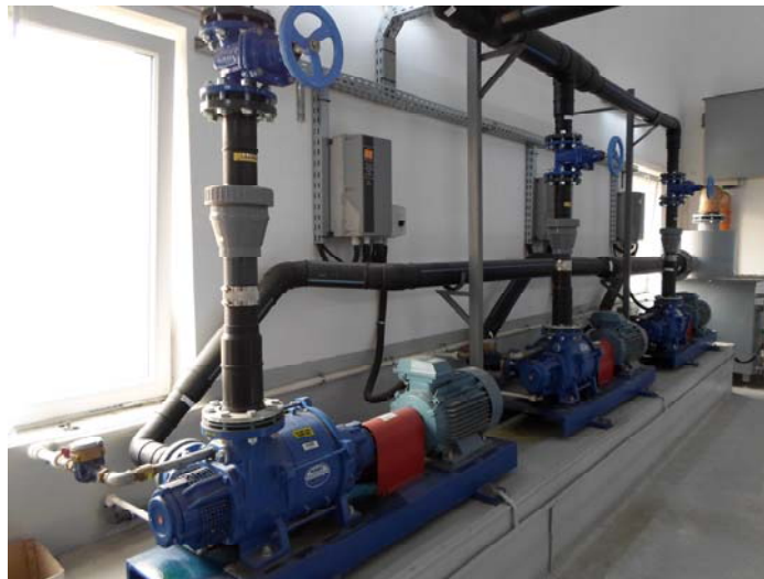
Fig. 4.12 Pompele de vacuum de la stația de vacuum din localitatea Bors
