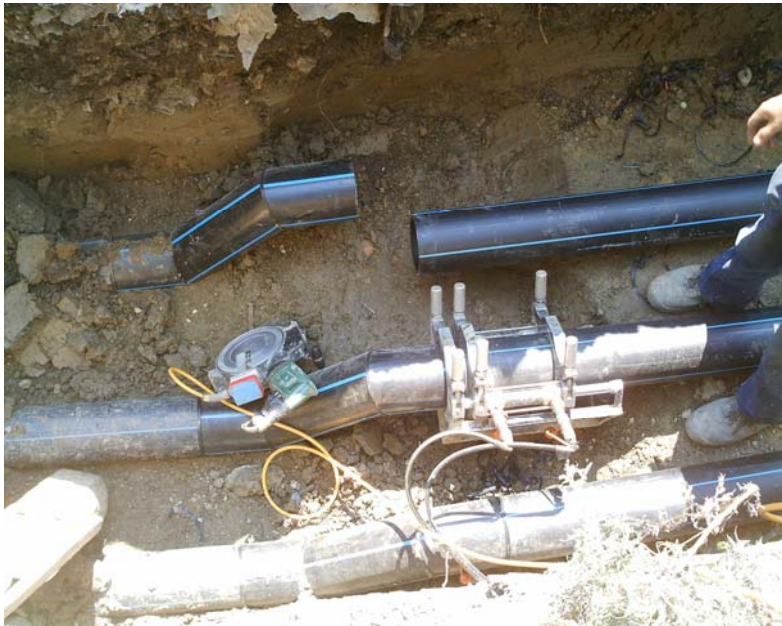
Fig.5.9 Sudură prin electrofuziune
