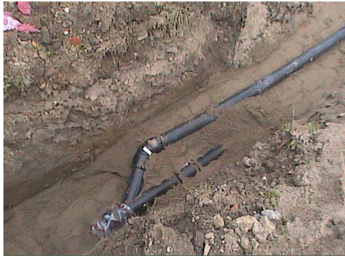
Fig.5.15 Montare conduct PE
