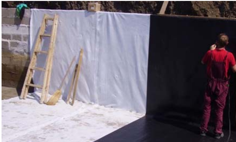
Fig. 5.16 Execuție clădire stație de vacuum
