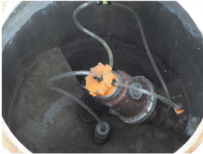
Fig. 4.10 Cămin colector/ de vacuum în localitatea Borș, județul Bihor
