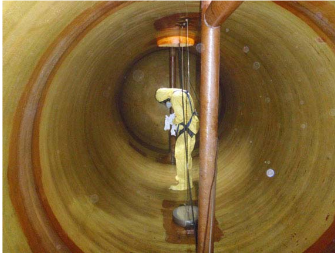
Fig.5.20 Curățare rezervor de vacuum
