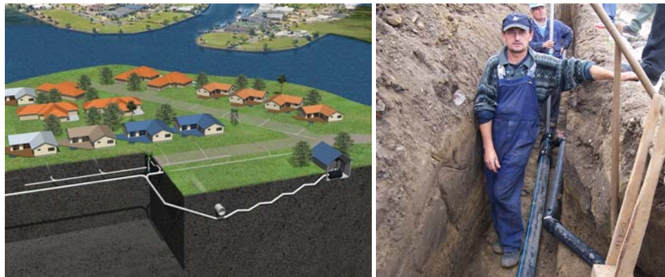
Fig. 1.2 Execuție sistem de canalizare vacuumat
