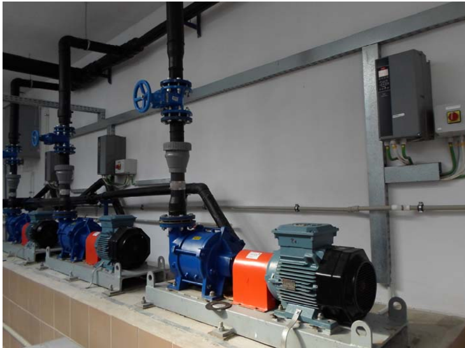
Fig.4.24 Pompele de vacuum din cadrul stației de vacuum din localitatea Pericei, județul Sălaj
