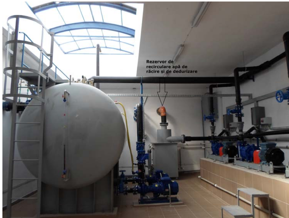
Fig. 4.25 Instalația de dedurizare a apei de răcire din stația de vacuum, Pericei
