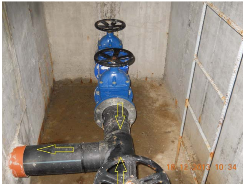
Fig.4.18 Intersecție conductă de refulare Borș - Sântion
