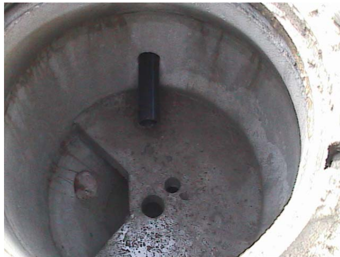
Fig.5.12 Instalarea unui cămin colector
