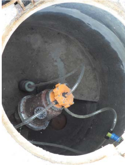
Fig. 4.21 Cămin colector/ de vacuum în localitatea Pericei, județul Sălaj
