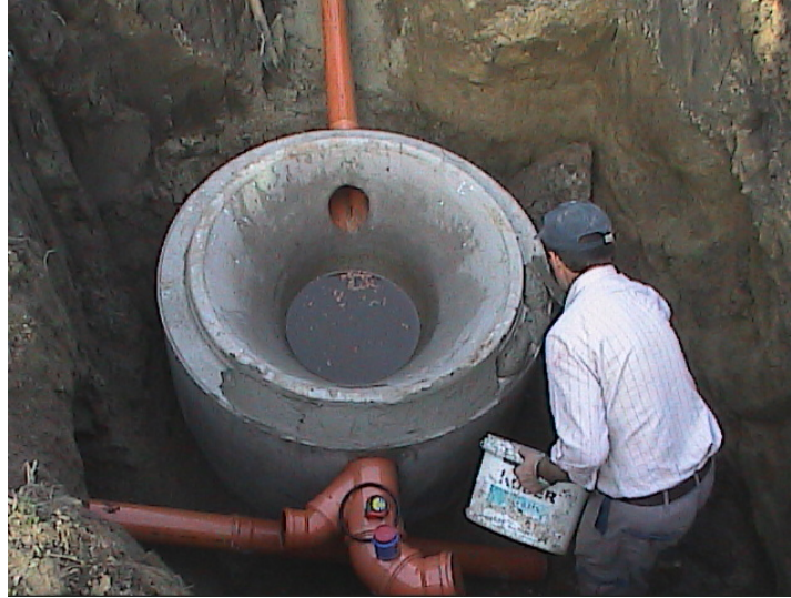
Fig.5.11 Jompul de la baza căminului colector
