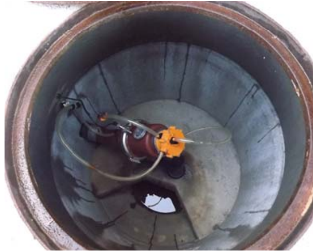
Fig.5.19 Cămin colectoare cu supapă – localitatea Pericei
