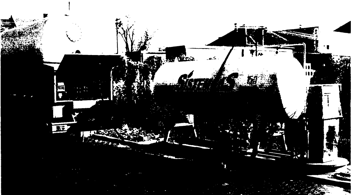
Fig.2.1. Încărcarea rezervorului fix de GPL.
