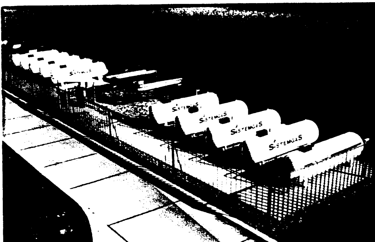
Fig.2.3. Baterii de rezervoare pentru instalații industriale de GPL
