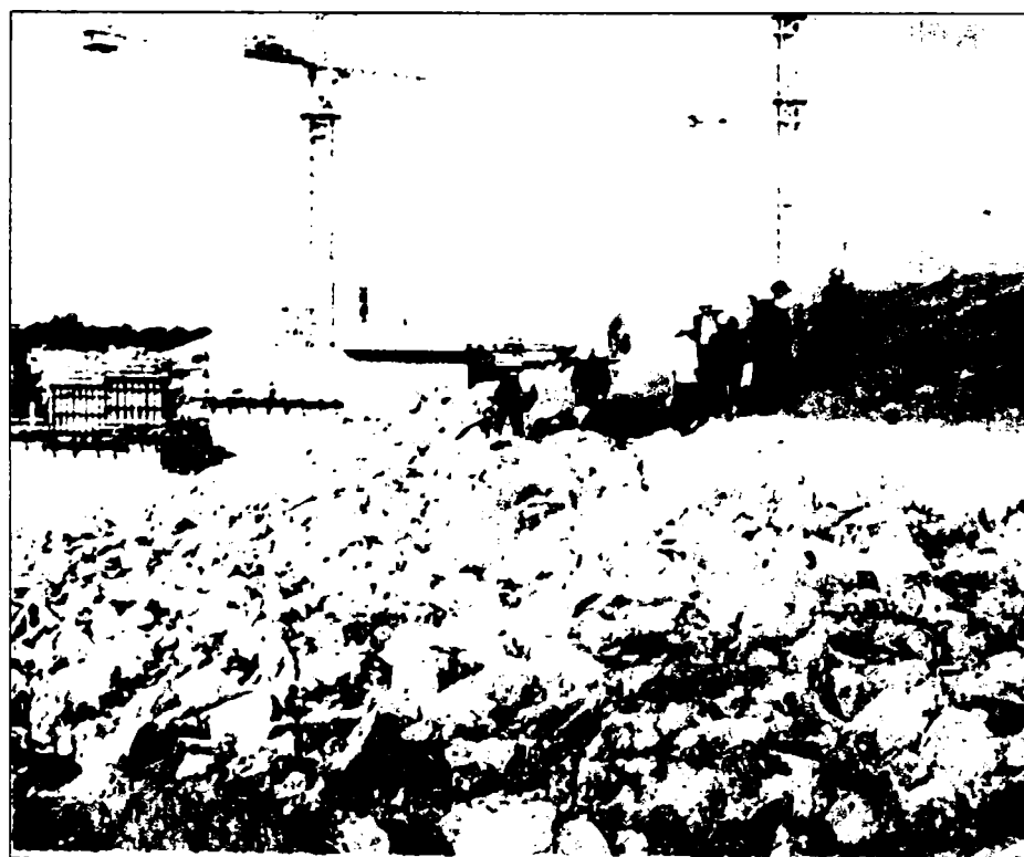
Fig.3.39. Protecția geotextilelor cu anrocamente
