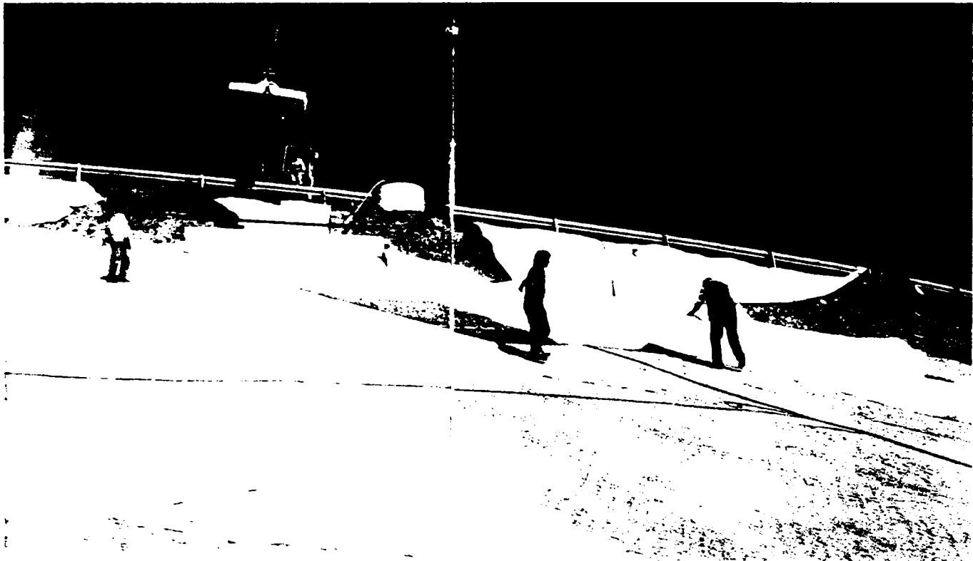
Montare cablaj Sistem TAUPE la depozitul Karlsruhe West – Germania
