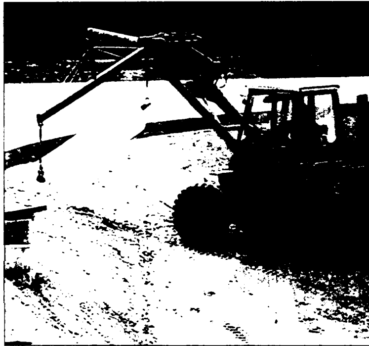
Fig.3.26. Așternerea mecanizată a geotextilelor
