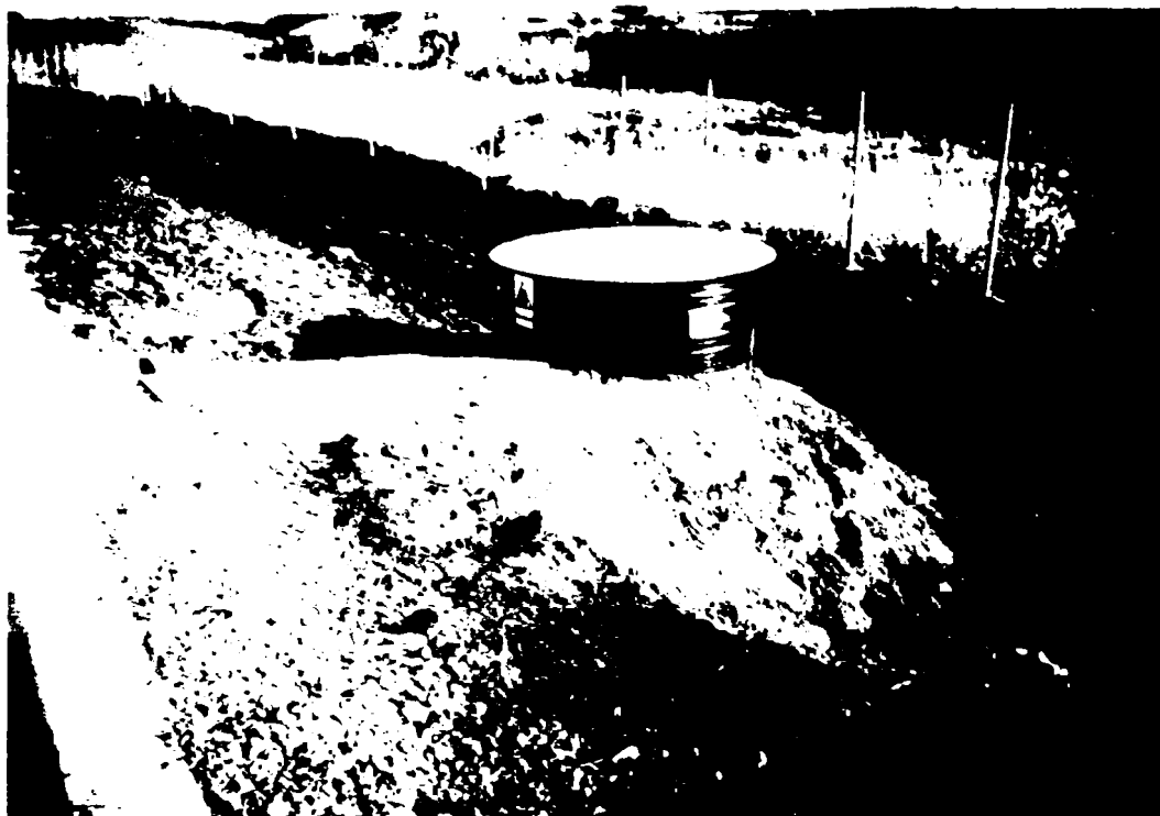
Fig. 1.25. Căminul de colectare, levigat din exteriorul depozitului prevăzut cu sifon, pentru neadmiterea aerului în depozit la A.S.A. – Arad
