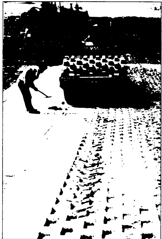
Fig.3.22. Compactarea suprafeței pe care se va așeza geotextilul
