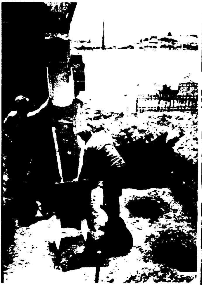
Etapa a II-a Betonarea pilotului scurt forat a- cu tubul din PVC
