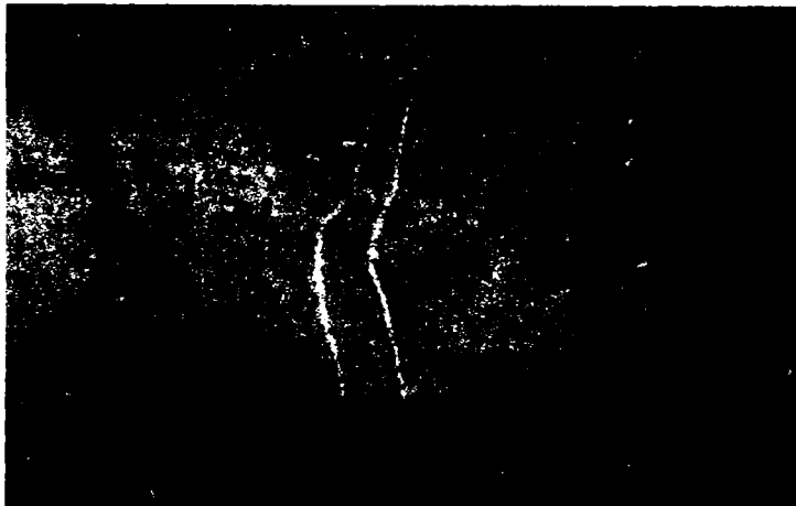
Apariția microfisurilor în radierul de beton armat de la cei doi piloți
