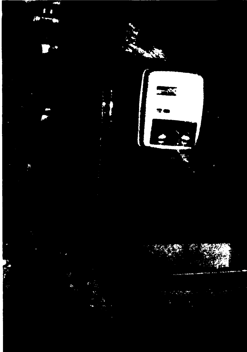
Foto 6.10 – Boiler pentru apă caldă menajeră ce funcționează cu biogaz
