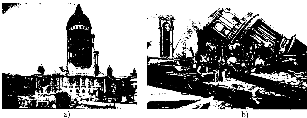
Figura 2.1 Efectele cutremurului asupra clădirilor: a) Avarii la clădirea primăriei din San Francisco; b) Prăbușirea clădirii primăriei din Santa Rosa
