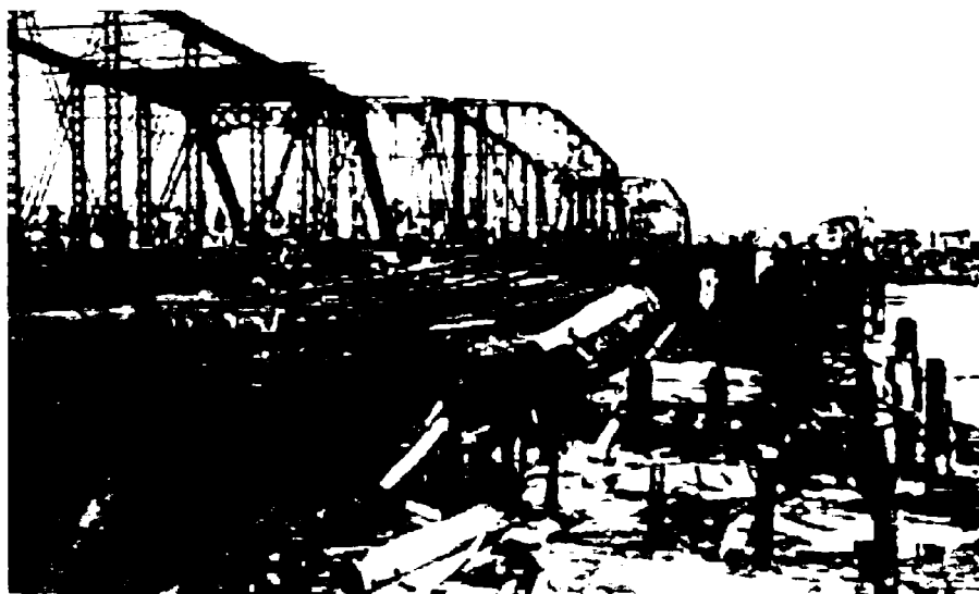
Figura 2.4 Podul Eitaibashi distrus de cutremur, Tokyo 1923
