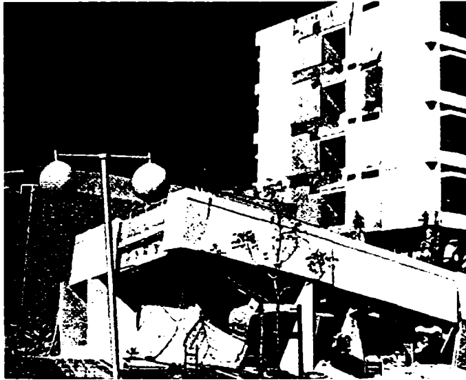
Figura 2.6 Avarii extinse la clădirea spitalului Olive View Community din Sylmar, construită cu puțin timp înainte de producerea cutremurului
