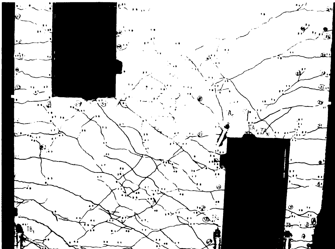
Figura 5. 12 Distribuția fisurilor în zona dintre goluri
