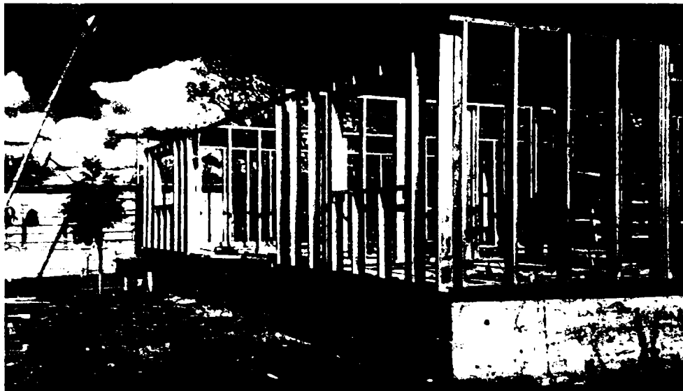
FIGURA VII-12. FAȚADA CONSTRUCȚIEI, NEACOPERITĂ
