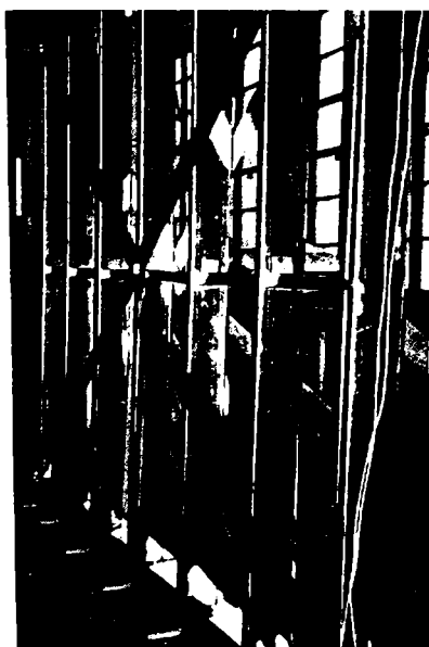
FIGURA III-27. FLAMBAJUL BENZILOR DE CONTRAVÂNTUIRE COMPRIIMATE
