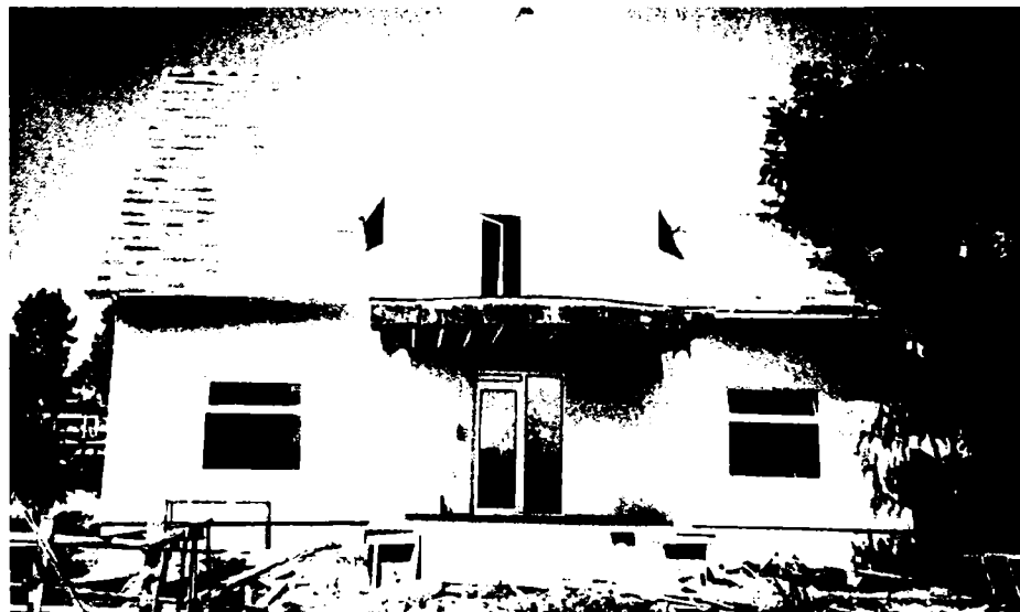
FIGURA VII-13. FAȚADA FINISATĂ A STRUCTURII
