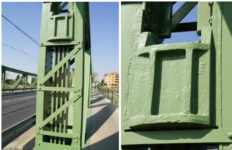
Figura 4.6.1.15. Consolidare pendulul mare
