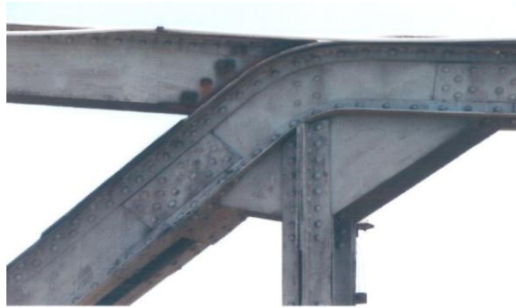
Figura 1.5.2.3. Bara falsă de la talpa superioară
