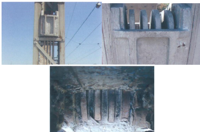
Figura 5.4.2.6.. Starea articulației Gerber
