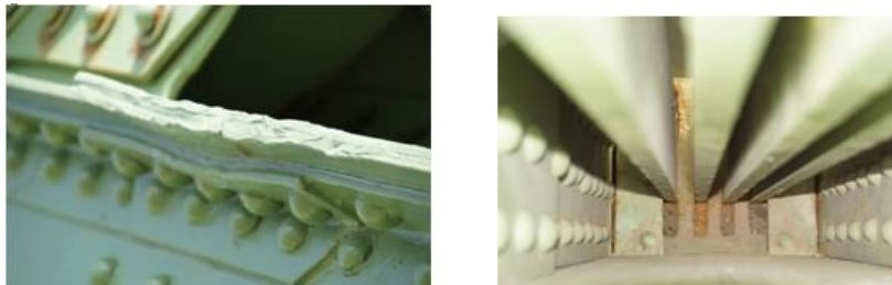
Figura 5.5.5. După consolidare bara cu ochi și diagonală
