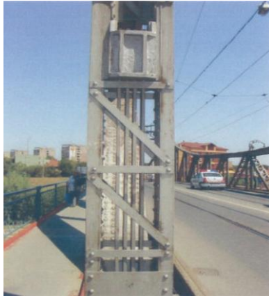
Figura 1.5.2.1.5. Montant în componența căruia se afla bara cu ochi
