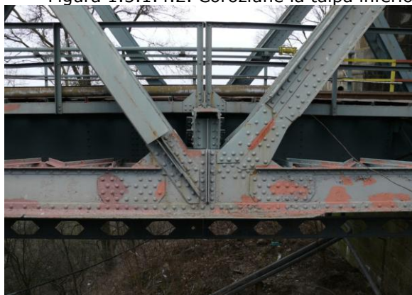
Figura 1.5.1.4.3. Contravântuiri nituite ascendente și descendente
