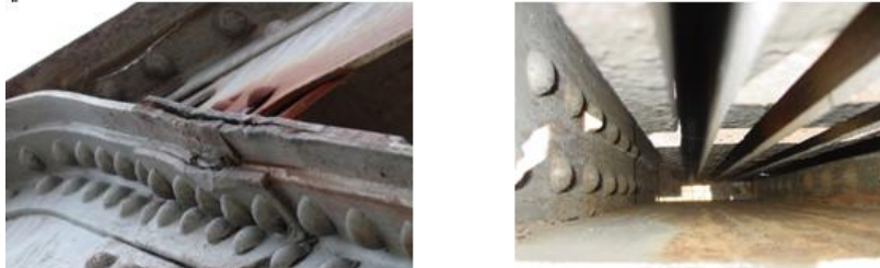
Figura 5.5.4. Înainte de consolidare bara cu ochi și diagonală
