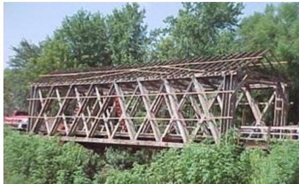
Fig. 1.1.5. – Pod din lemn sistem Howe
