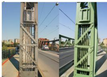
Figura 5.5.3. Înainte și după consolidare bara cu ochi de 1240 mm
