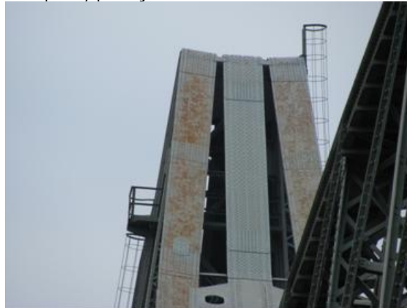
Figura 1.5.1.5.1. Cele 2 tălpi superioare corodate
