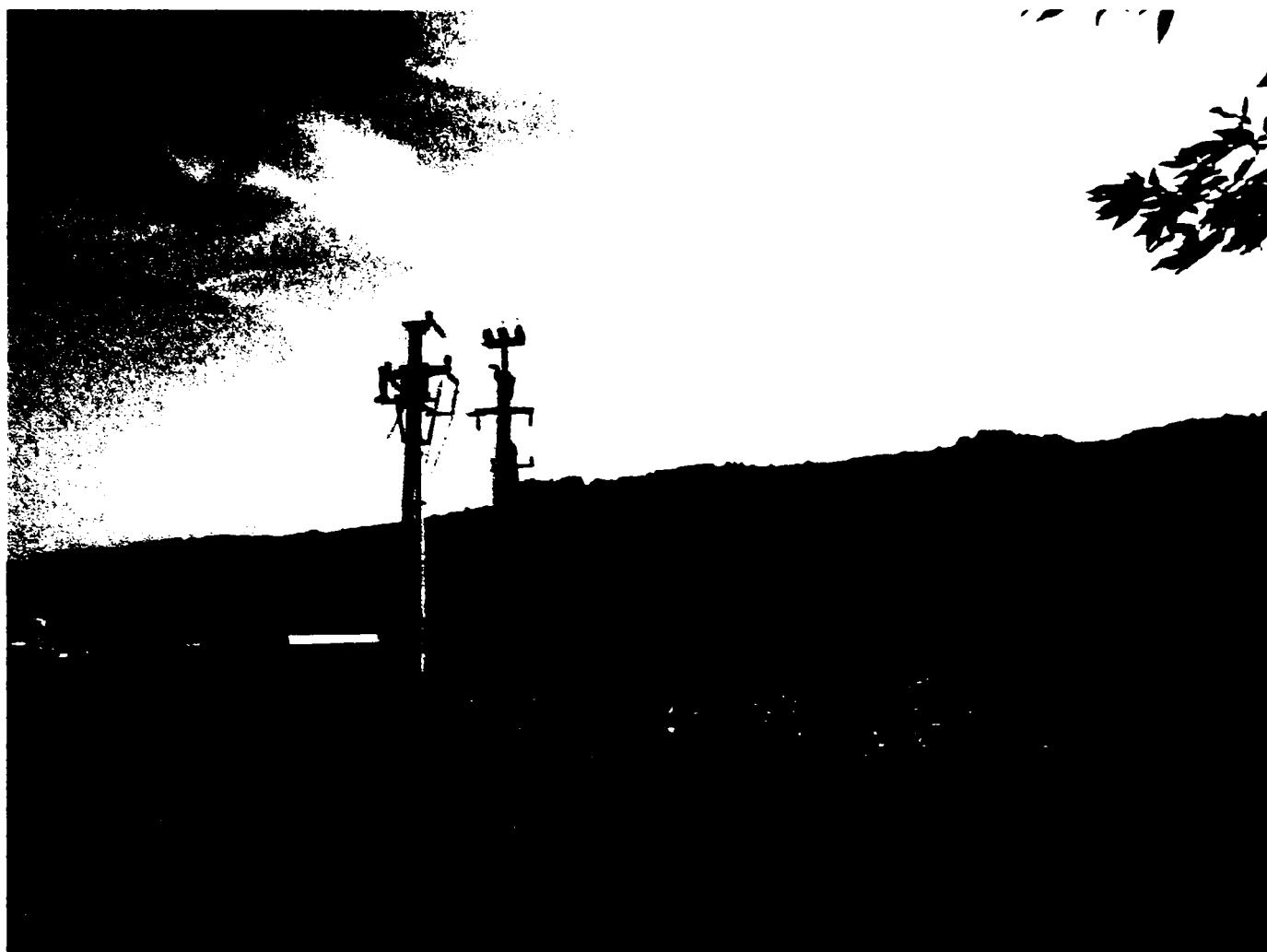
Fig. 5.1. Stâlpul terminal nr.343 al LEA 20 kV Hațeg – Baru Mare
