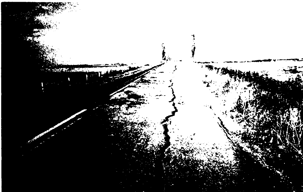
Fig.5.34. Crăpături longitudinale în zonele marginale
