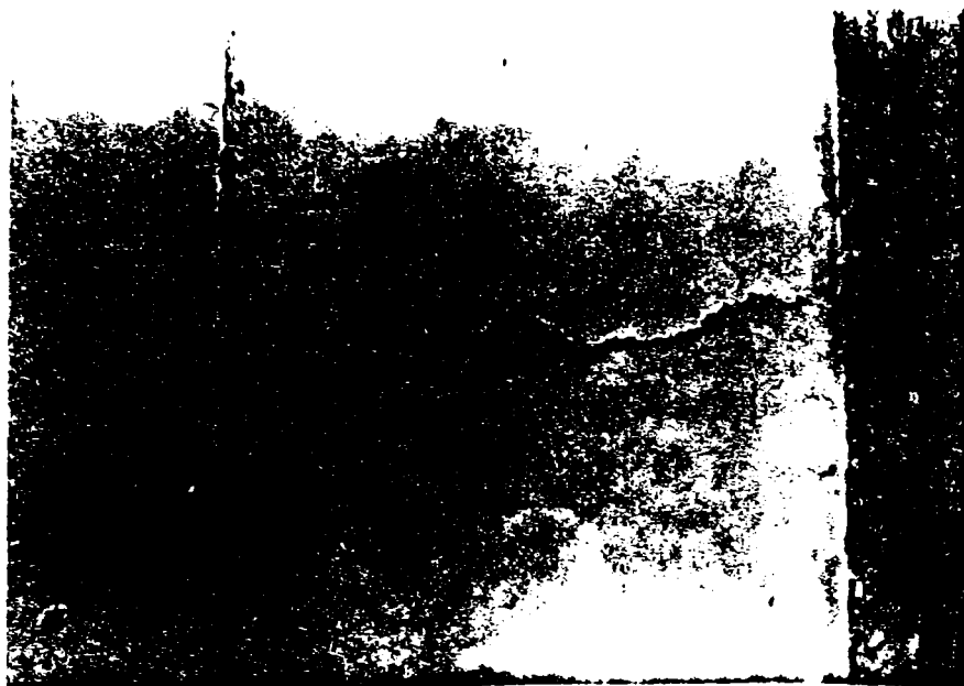
Fig.5.13. Crăpătură transversală
