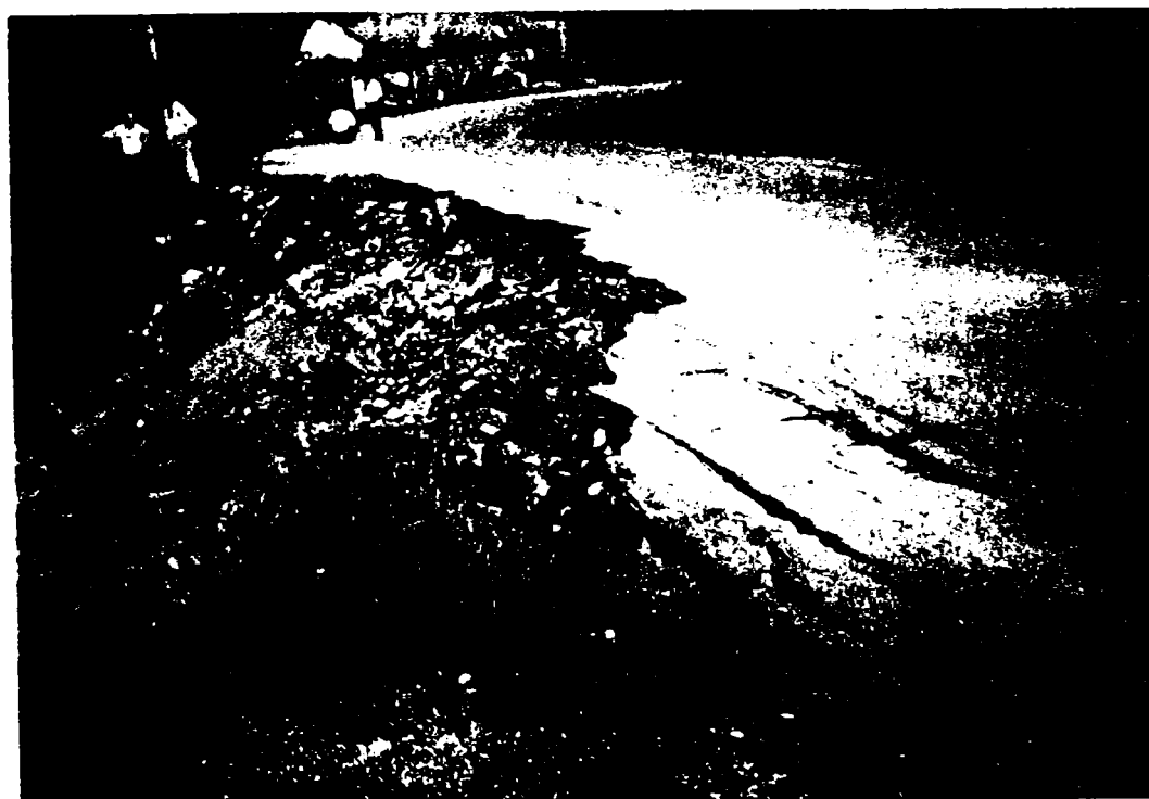
Fig.5.12. Terasament de drum afectat de alunecare de teren
