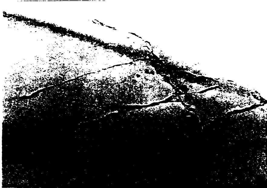
Fig. 5.16. Fisuri și crăpături diagonale
