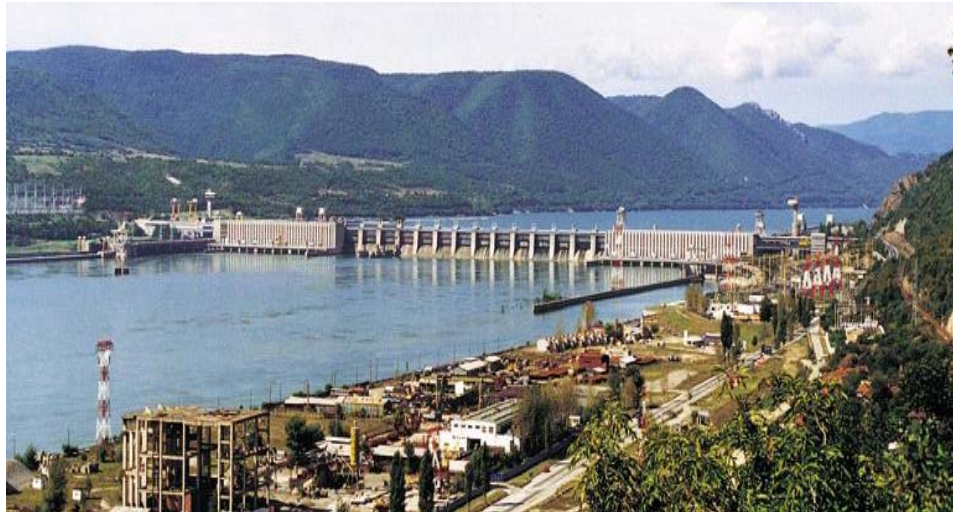
Figura 1.3 Imagine de ansamblu a CHE Portile de Fier I Partea stângă a centralei aparține Serbiei, partea dreaptă României [29]
