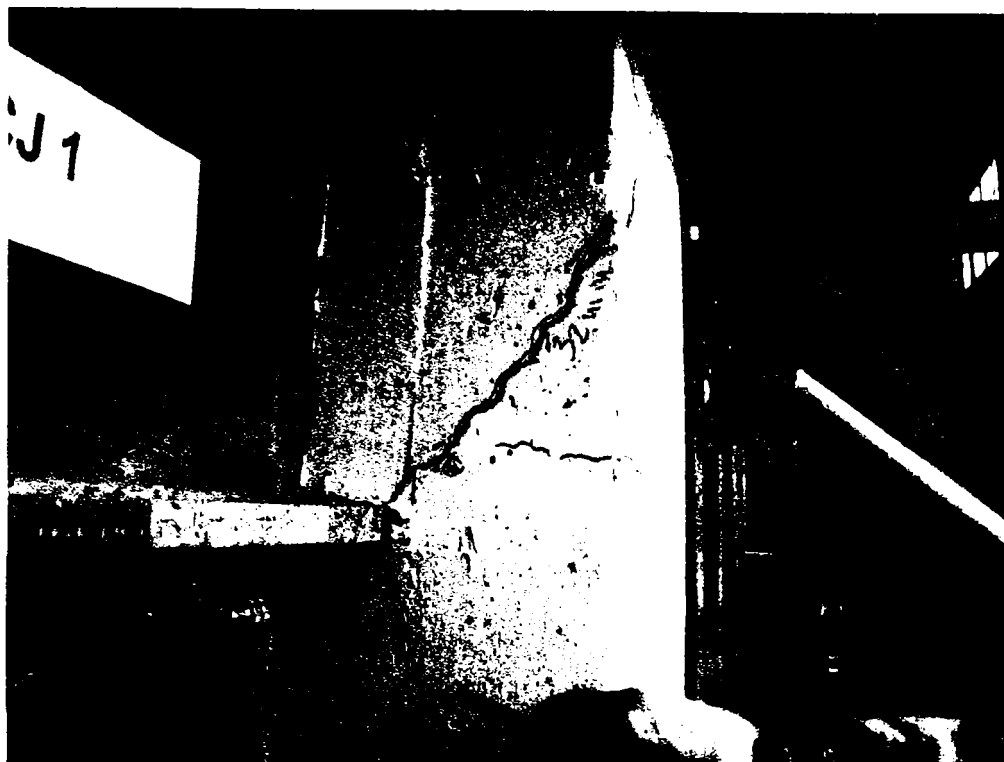
Foto 4.41 - Dezvoltarea fisurilor de la nivelul tăpii întinse
