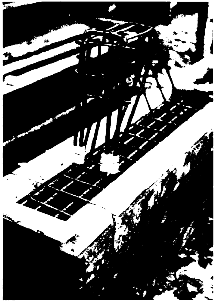
Foto. 5.3. Armarea și cofrarea consolei CV41
