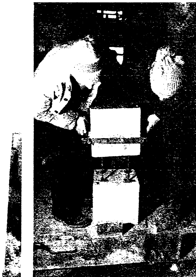
Fig.6.28 Realizarea îmbinării stâlp-stâlp
