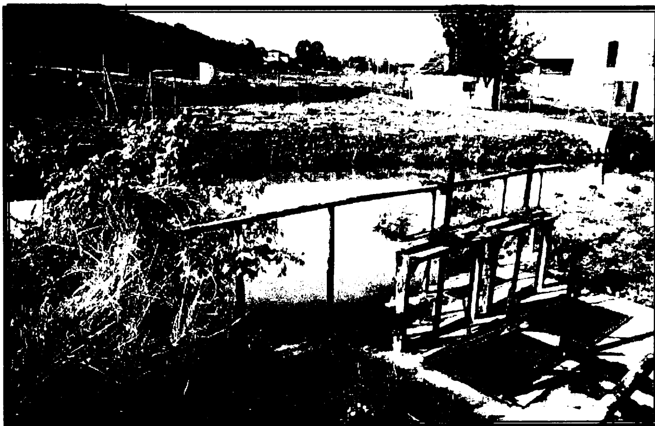
Fig.2.2. Stăvilarul care oferă condiții concrete în realizarea microstației de pompare.
