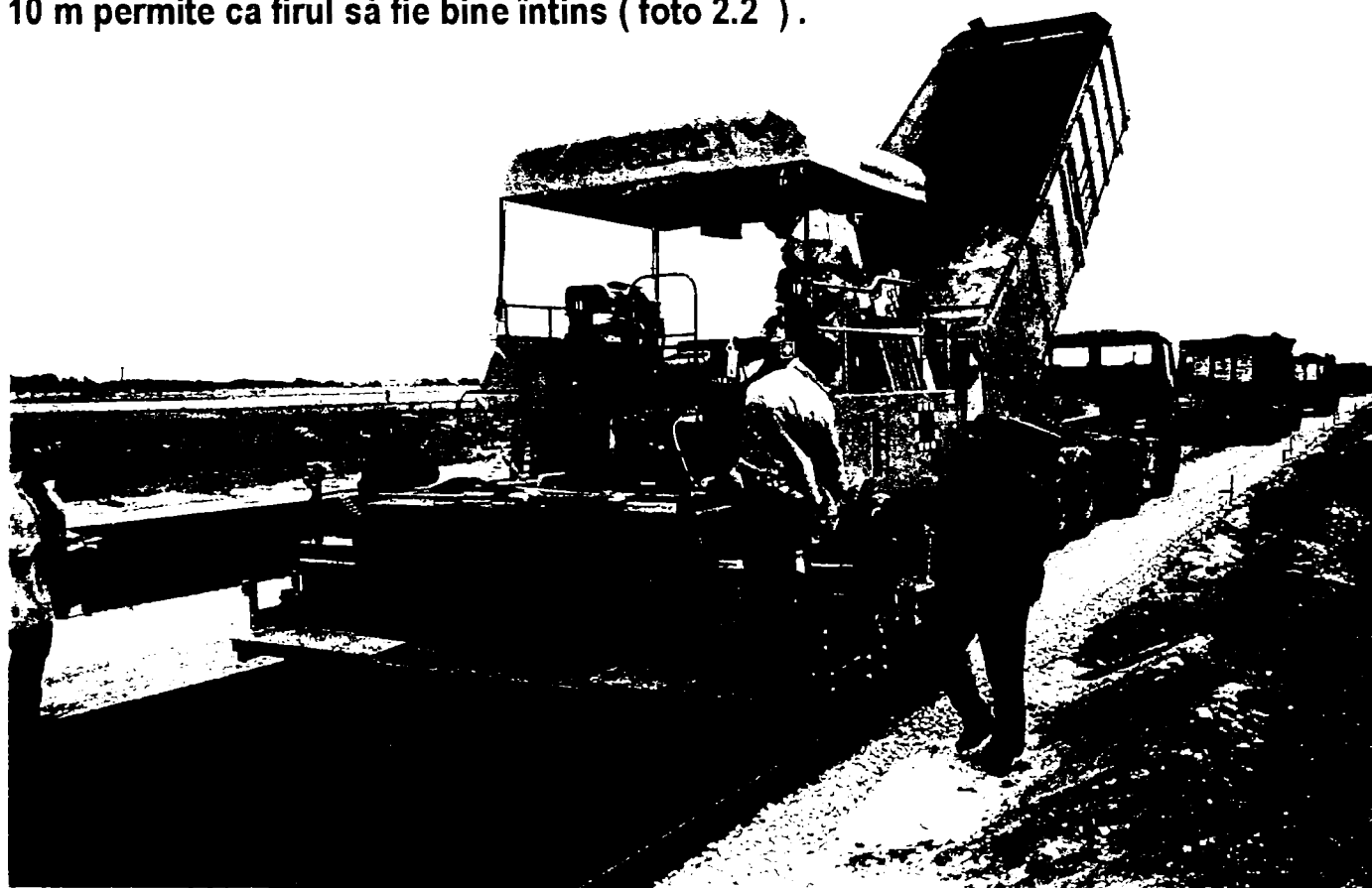
FOTO 2.2 - așternerea unui strat de egalizare din mixtură asfaltică
