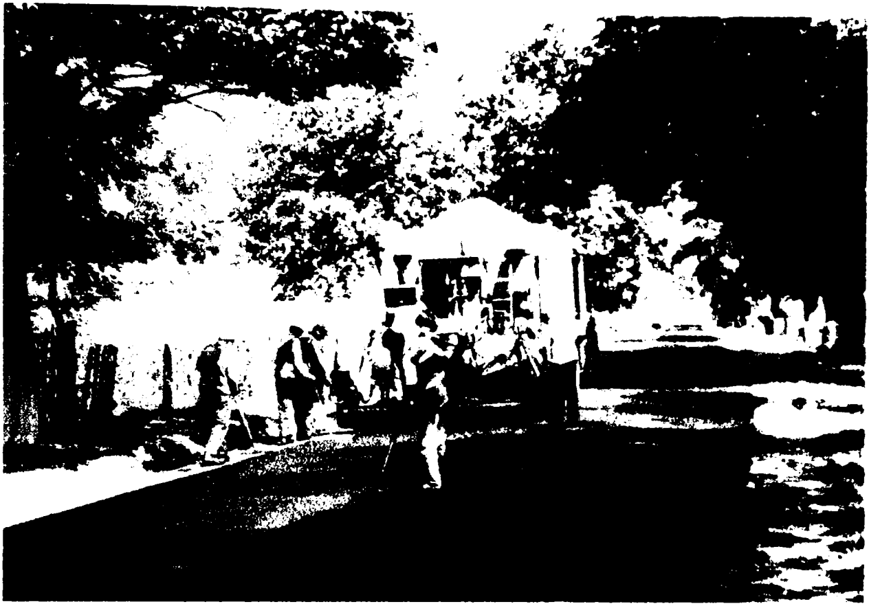
Fig. 2.26. Utilaje pentru aşternerea covoarelor asfaltice subţiri din mortar asfaltic.
