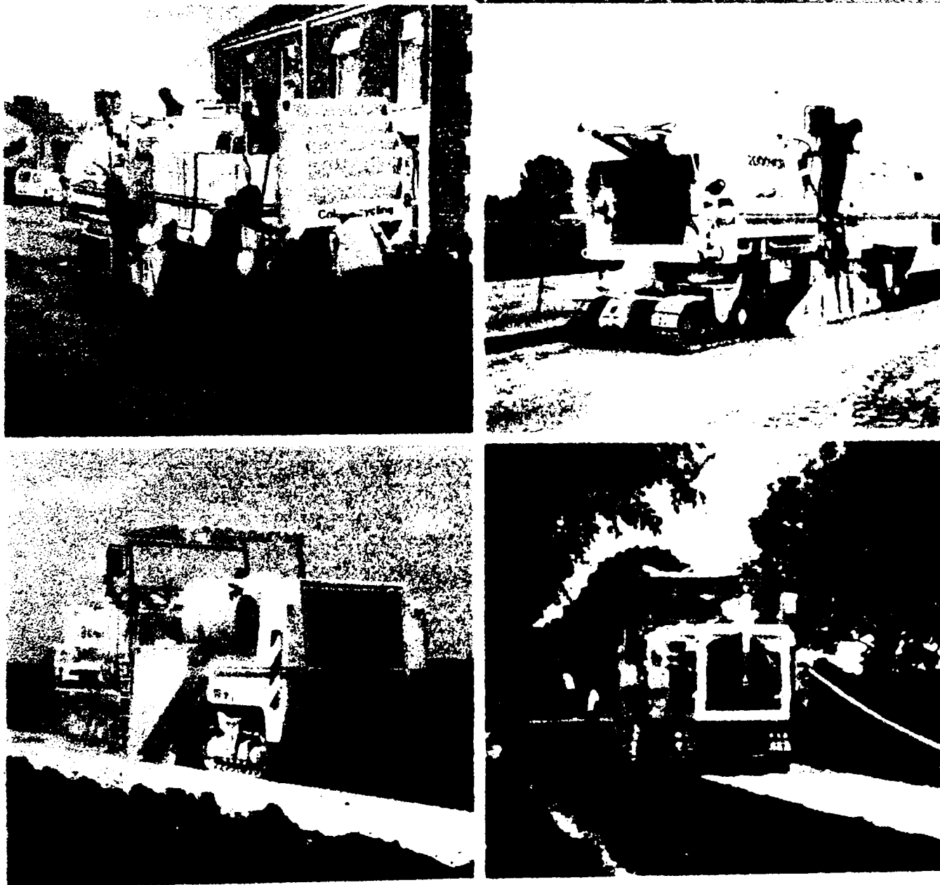
Fig. 2.14. Frezare-reutilizare mixturi "la rece" și stabilizări infrastructuri "in situ".
