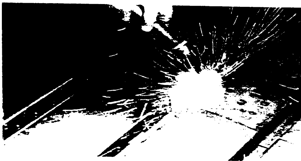
Fig. 5 12. Imbinarea panourilor de tablă pentru plăcile continue
