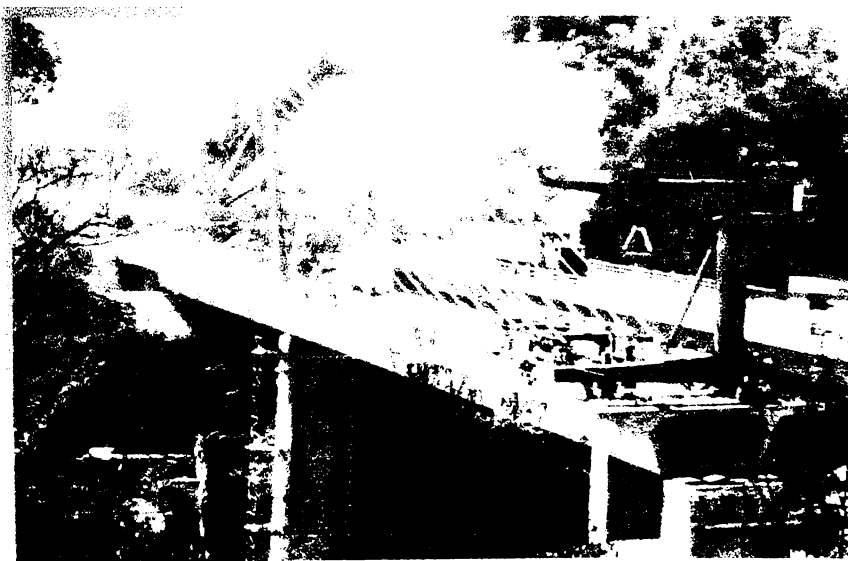
Foto 4.13 - Viaductul Vallon des Fleurs construit prin avansare din elemente prefabricate
