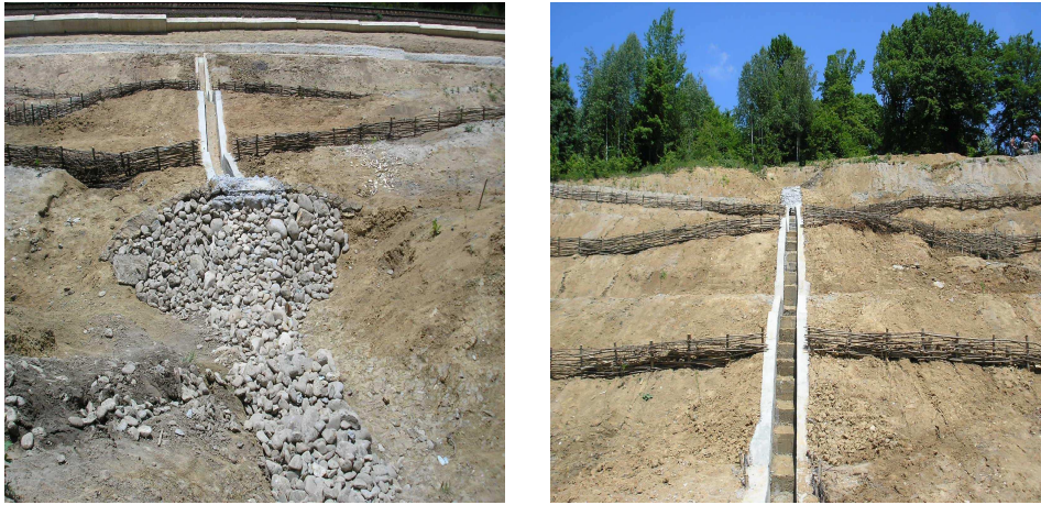
Fig. 6.39 Terasarea și evacuarea apelor de pe versant
