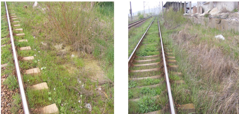
Fig.5.23 Apa stagnează la baza terasamentului linia 200 km.510+300 - 510+600
