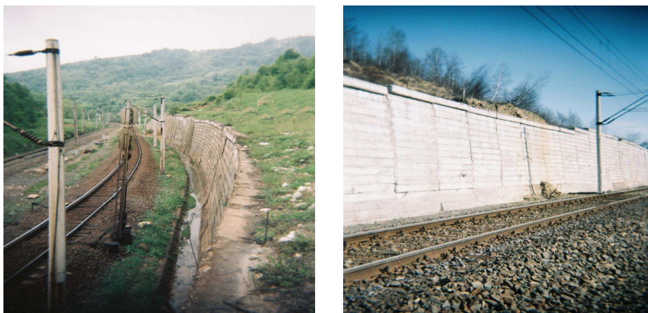
Fig. 6.27 Linia de cale ferată 116 Simeria - Livezeni km.60 + 750
