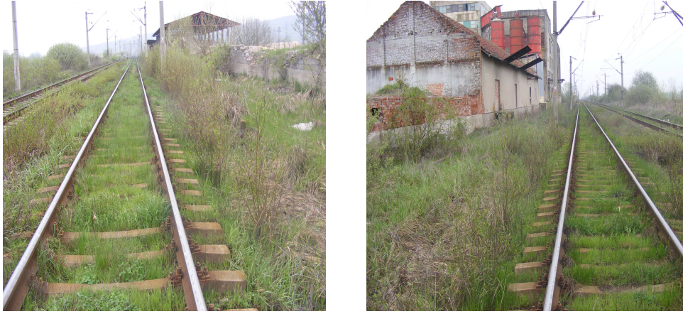
Fig.5.24 Linia industrială capăt X stația Gurasada km.510+300 - 510+600
