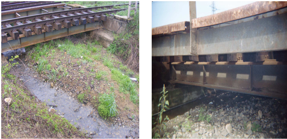
Fig.5.26 Albie pârâu colmatată linia 200 stația Câmpuri Surduc km.514+657
