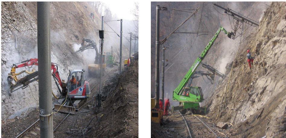
Fig.5.9 Execuția forajelor pentru tiranți
