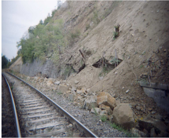
Fig.5.68 Alunecare taluz debleu
