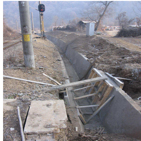
Fig.5.11 Șanț din beton armat pentru asigurarea scurgerii apelor
