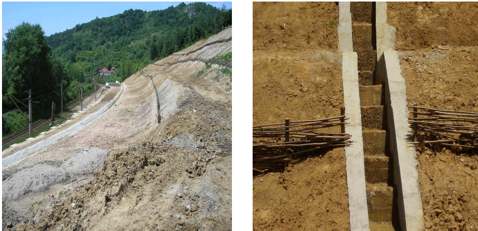
Fig.6.40 Detalii terasare versant și evacuarea apei
