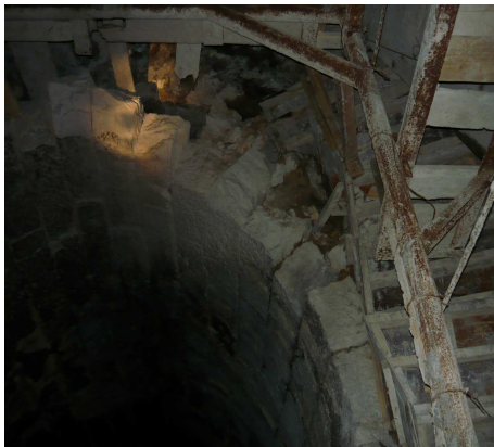
Fig.5.61 Intradosul tunelului - zidărie din moloane
