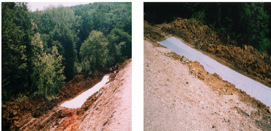
Fig.6.20 Contrabanchetă armată cu geogriile
