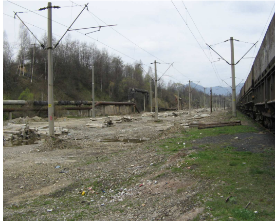
Fig.5.47 Platforma stației Livezeni - linii desființate
