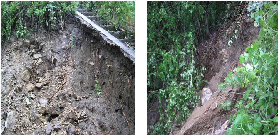
Fig.5.14 Fenomenul de eroziune la sfertul de con al podului de la km.448+075
