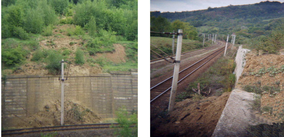
Fig.6.28 Alunecare versant peste zidul de sprijin
