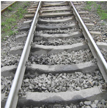
Fig.5.48 Zone noroioase în stația Livezeni
