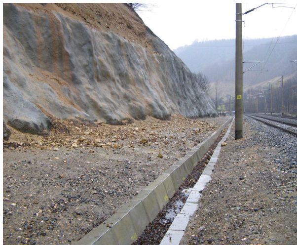
Fig.5.45 Șanț din elemente prefabricate km.73+960 - km.74+283
