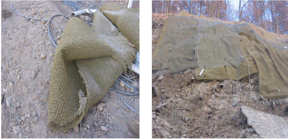
Fig. 5.8 Rularea împletiturii TECMAT pe versant
