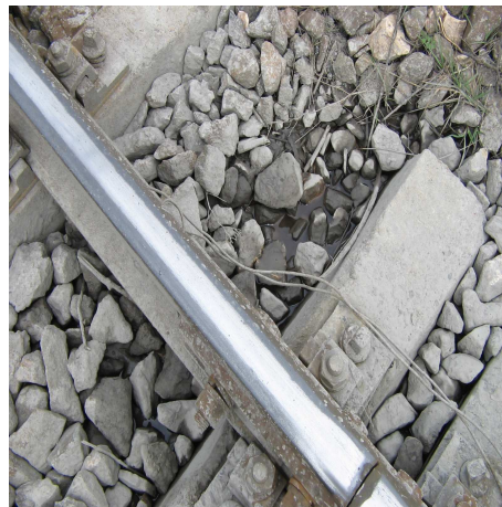
Fig.5.48 Zone noroioase în stația Livezeni
