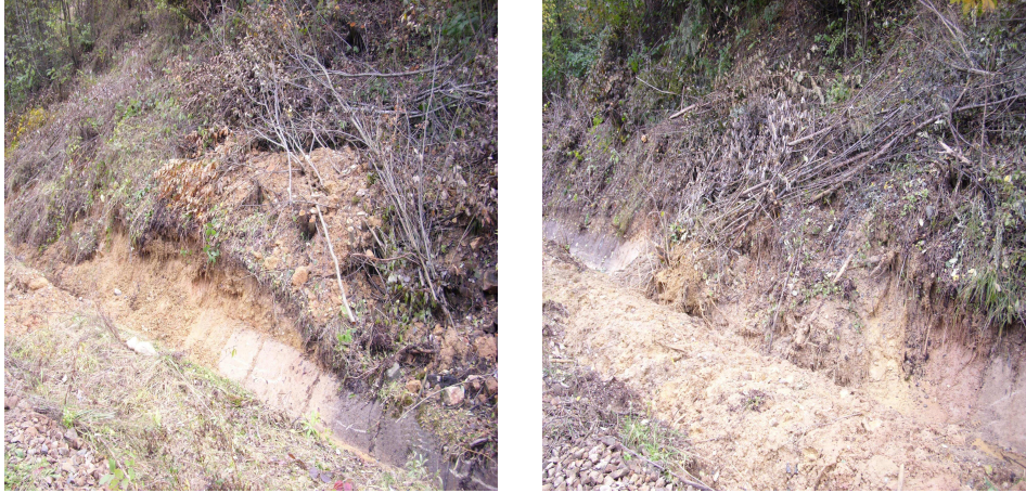
Fig.5.35 Alunecare de versant km.58+900 - km.59+100
