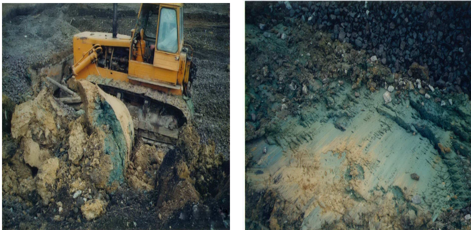
Fig.6.17. Teren natural - formațiuni argiloase
