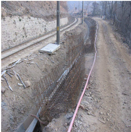
Fig.5.11 Șanț din beton armat pentru asigurarea scurgerii apelor
