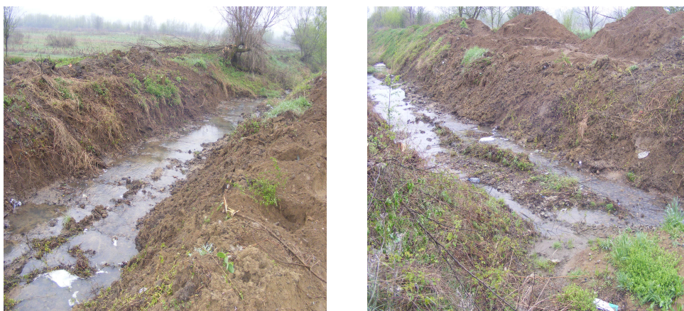
Fig.5.28 Lărgirea albiei unui pârâu km.514+657 linia 200 dubla II
