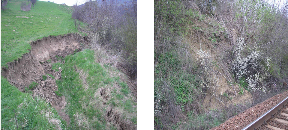
Fig.5.5 Versant instabil între stațiile de cale ferată Crușovăț și Domașnea km.428+750 - km.428+800
