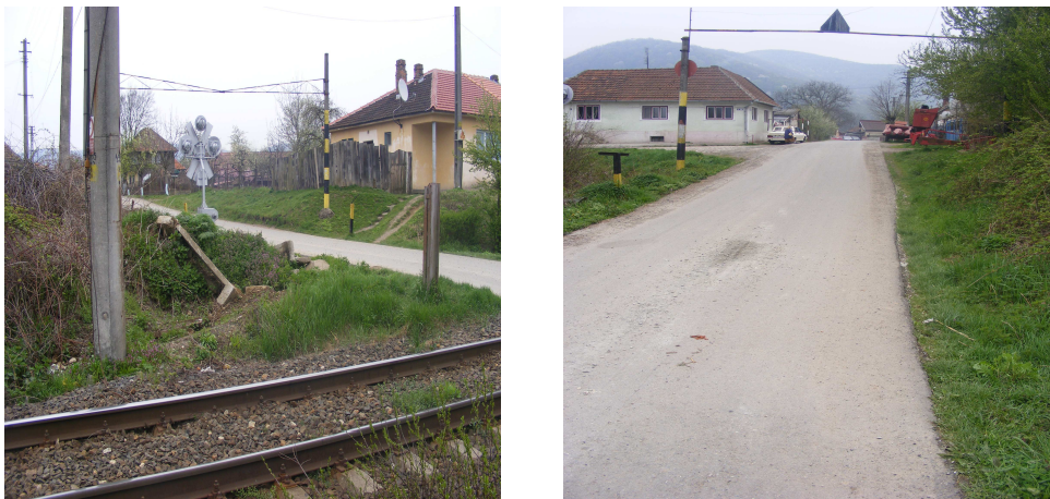
Fig.5.22 Stația de cale ferată Brănișca linia 200 trecere la nivel km.495+465
