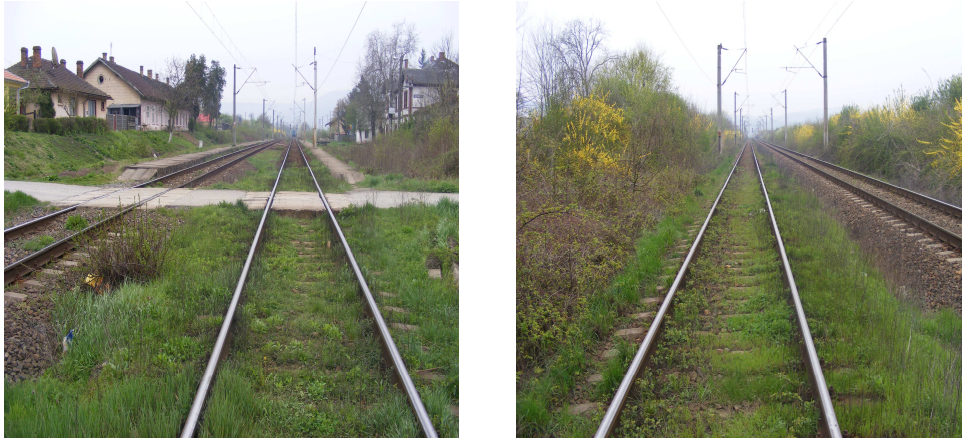
Fig.5.21 Stația de cale ferată Brănișca linia 200 dubla II km.494+900 - km.496+100
