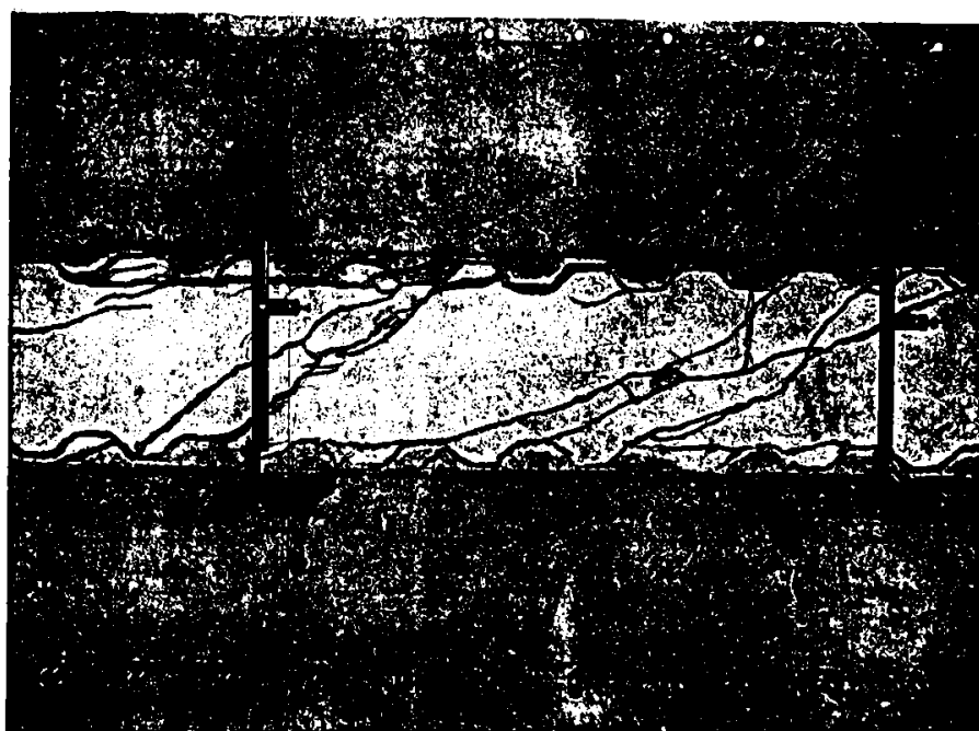
FOTO 5.18 FAȚA NORD DUPĂ CEDAREA ÎMBINĂRII DETALIU
