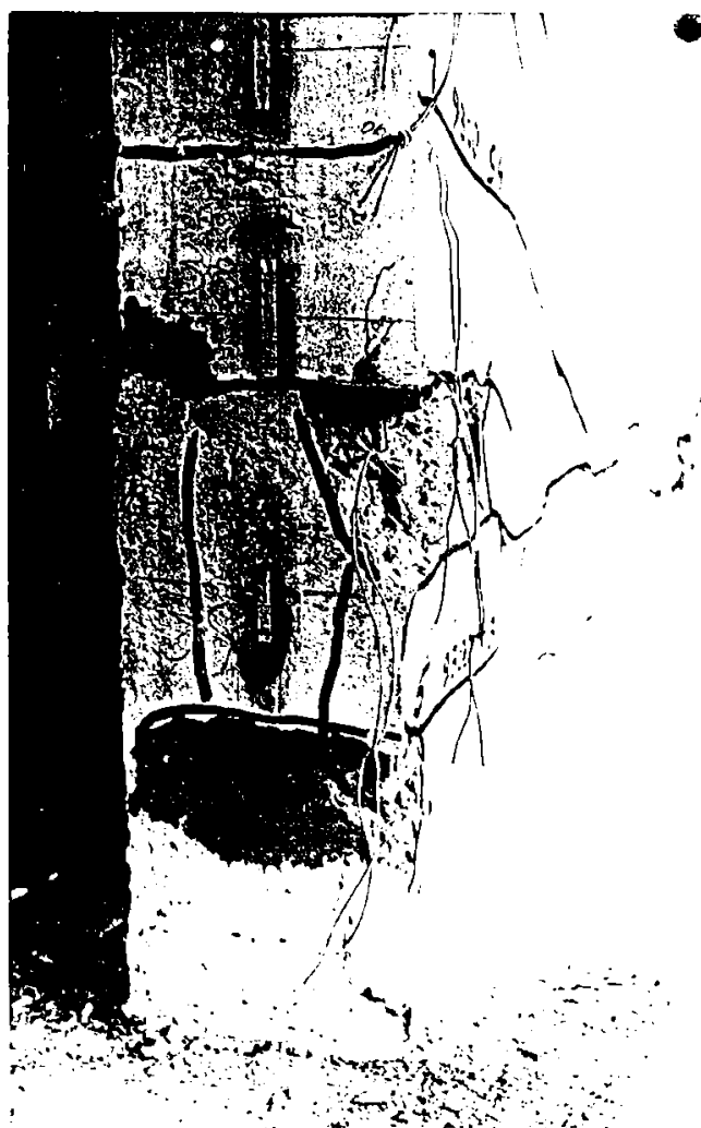
FOTO 6.15 MODEL EXPERIMENTAL F2 CEDARE - ZDROBIREA PARȚIALĂ A BETONULUI COMPRIMAT
