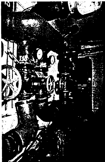
Fig. 5.29. Vedere a sistemului de pompare.
