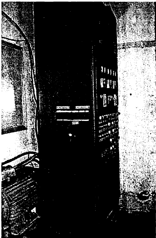
Fig. 5.31. Vedere laterală a tabloului TFA 1 și a motorului de acționare a pompei.
