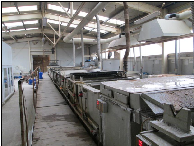
Fig.4.6. Hala de producție cu linia automată de protecție anticorozivă
