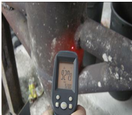
Fig.5.4.A. Măsurarea temperaturii blindajului
