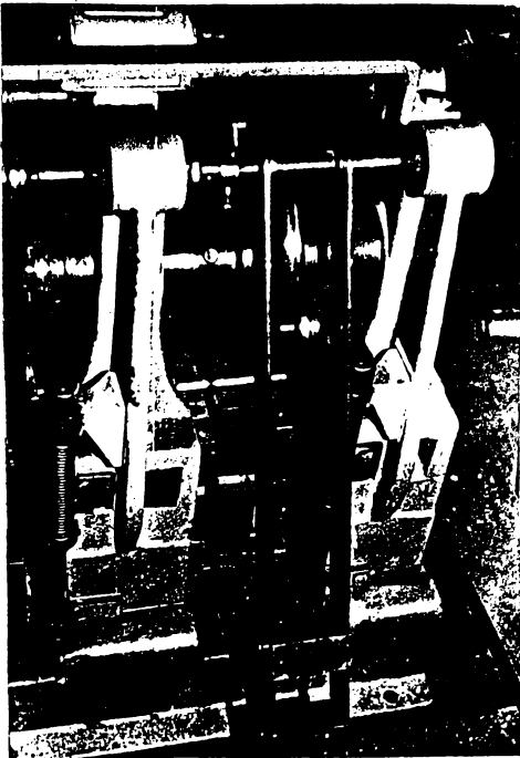
Fig. 5.14. Vedere a postului nr. IV.
