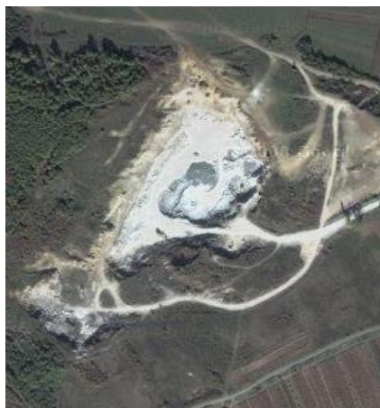
Fig. 2.4. Depozitul de șlam de aglomerare - furnale rezultat pe platforma industrială a S.C. Sidermet S.A. Călan [10,12]
