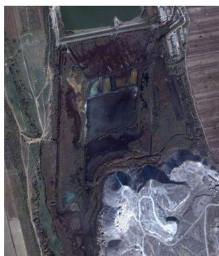
Fig. 2.8. Iaz decantor a șlamului de furnal și convertizor rezultat pe platforma industrială a combinatului S.C. ArcelorMittal Galați S.A. [10, 19]
