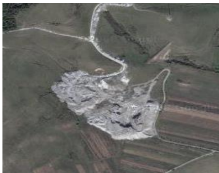
Fig. 2.14 Halda de zgură a combinatului S.C. Sidermet Călan S.A. [10,19]
