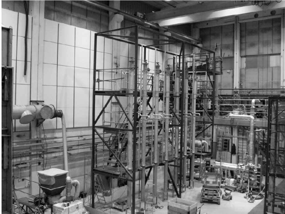
Figura 3.7. Instalație pilot de captare avansată cu amine, Centrul Tehnologic Global ECS (GTC), Växjö, Suedia, [123]
