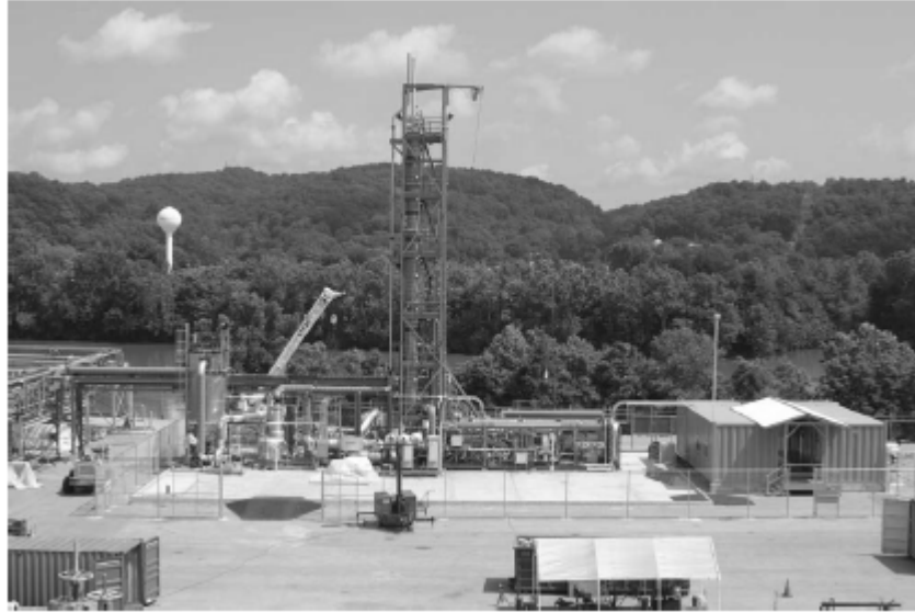
Figura 3.4. Pilotul industrial de la instalația Union Carbide, South Charleston, SUA
