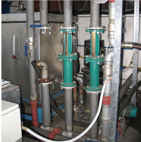
Fig.6.12. Montaj debitmetre de ulei
