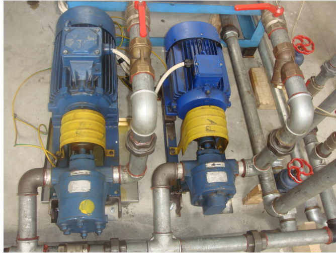
Fig.6.7 Pompele de ulei cu debitmetrele Vortex
