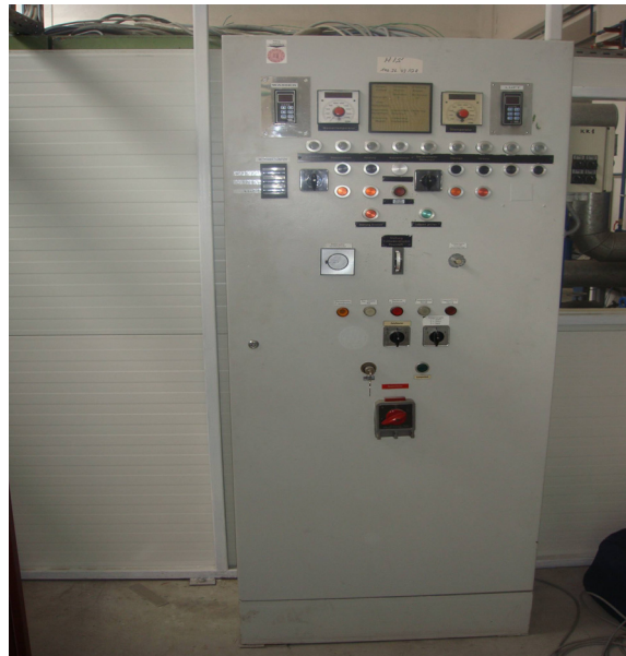
Fig.6.8. Panoul de comanda pentru pompele de ulei
