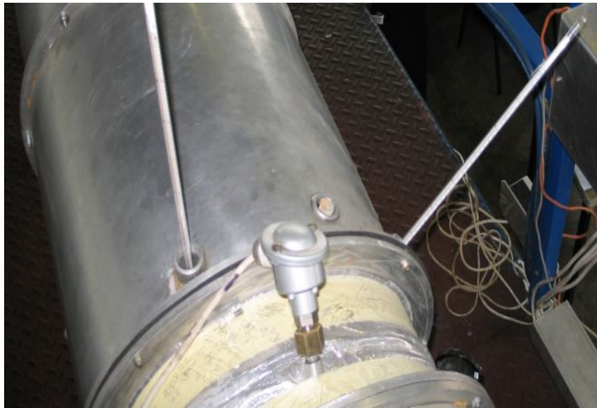
Fig.6.9. Dispunerea termometrelor și termorezistențelor pe canalul de aer
