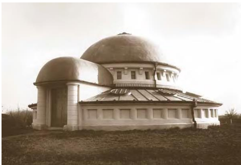
Fig.1.5. Clădire ce adăpostește un grup de foraje, 1914, sursa Aquatim S.A[80]
