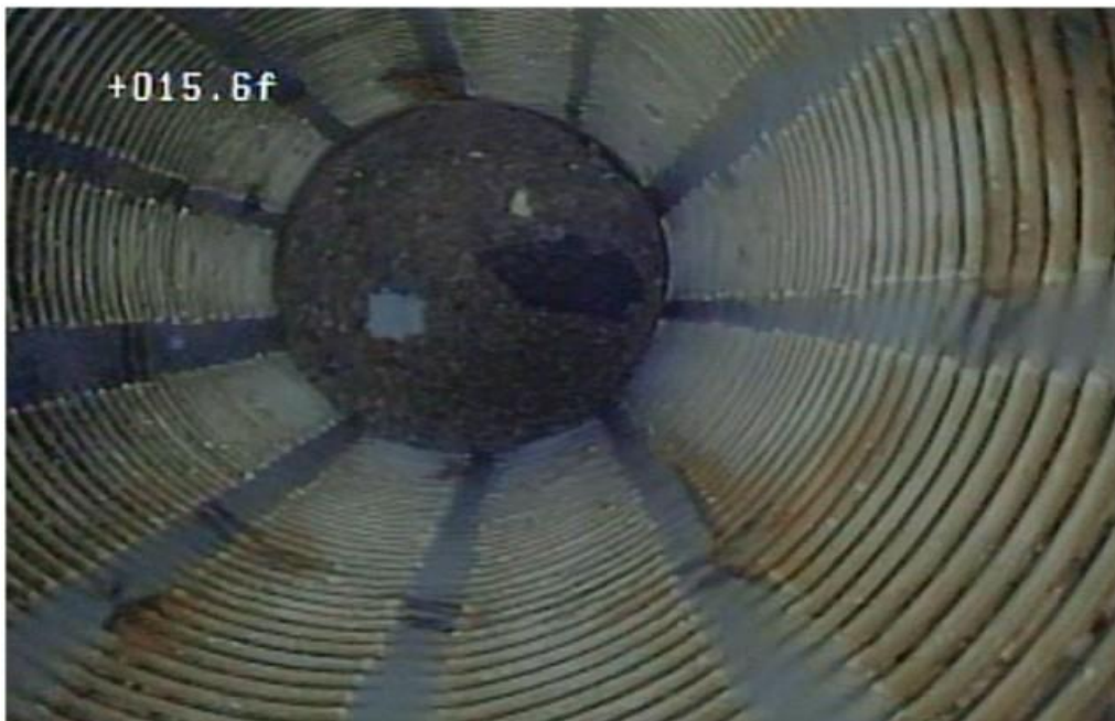
Fig.4.13. Exemplu vedere a unui foraj, reprezentare starea filtrului și calitatea apei
