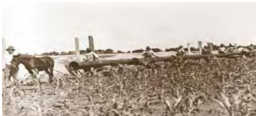
Fig. 1.6. Lucrări pentru execuția rețelei de apă, 1914, sursa Aquatim S.A.[80]
